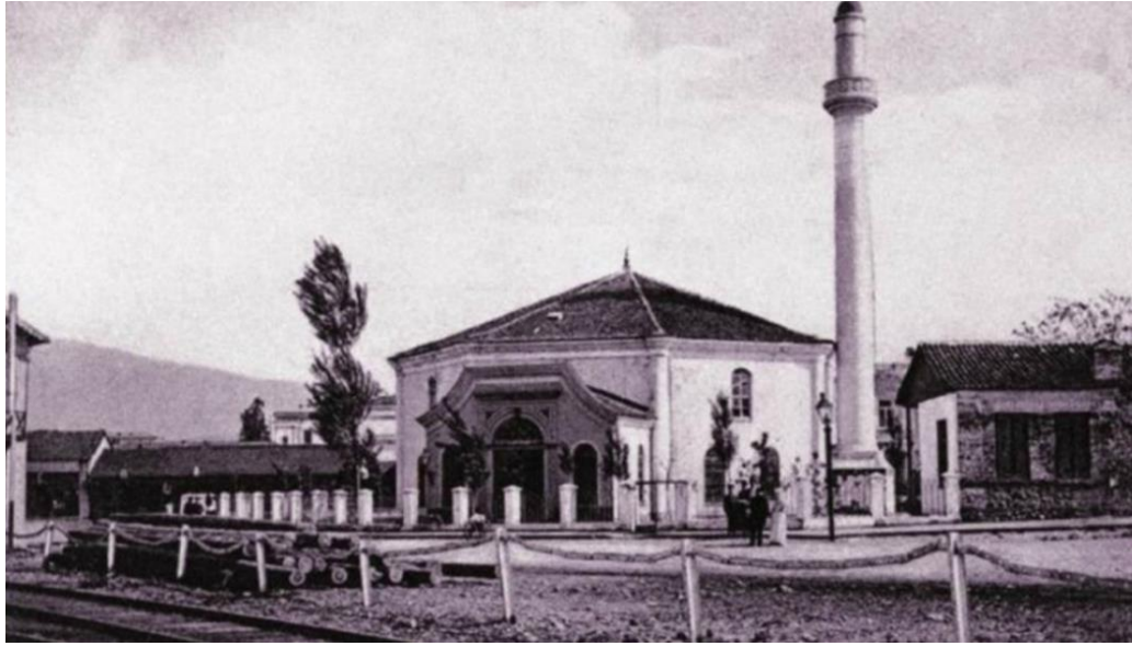
Şekil 2.1. Batum Aziziye Camisinin Ön Cephe Görünüşü 532
