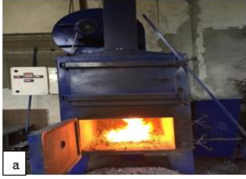
Şekil 3.5. Kümeslerde katı yakıtlı (a) ve infrared (b) ısıtma sistemi
