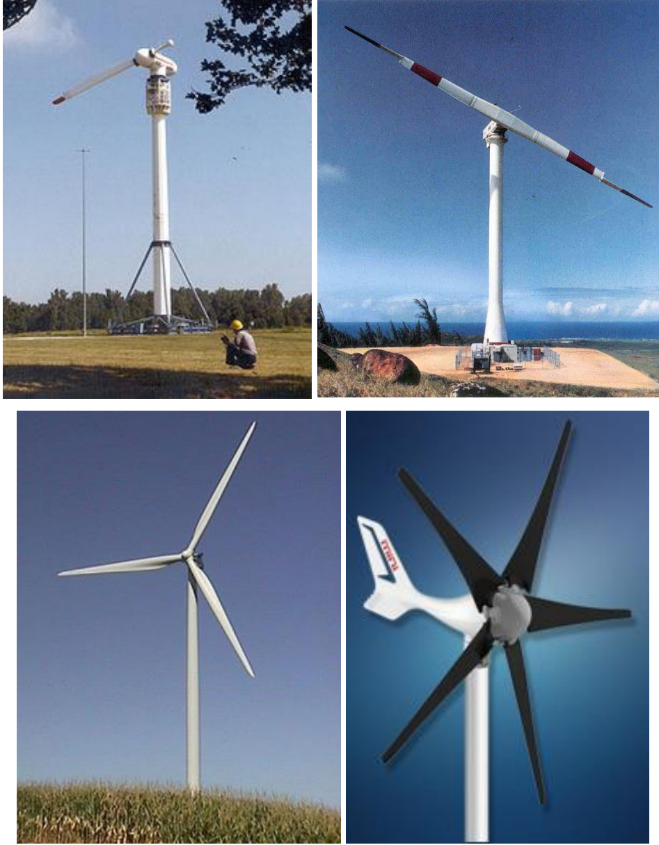
Şekil 4.10. Kanat sayısına göre yatay eksenli rüzgar türbinleri (Kaya, 2014).
