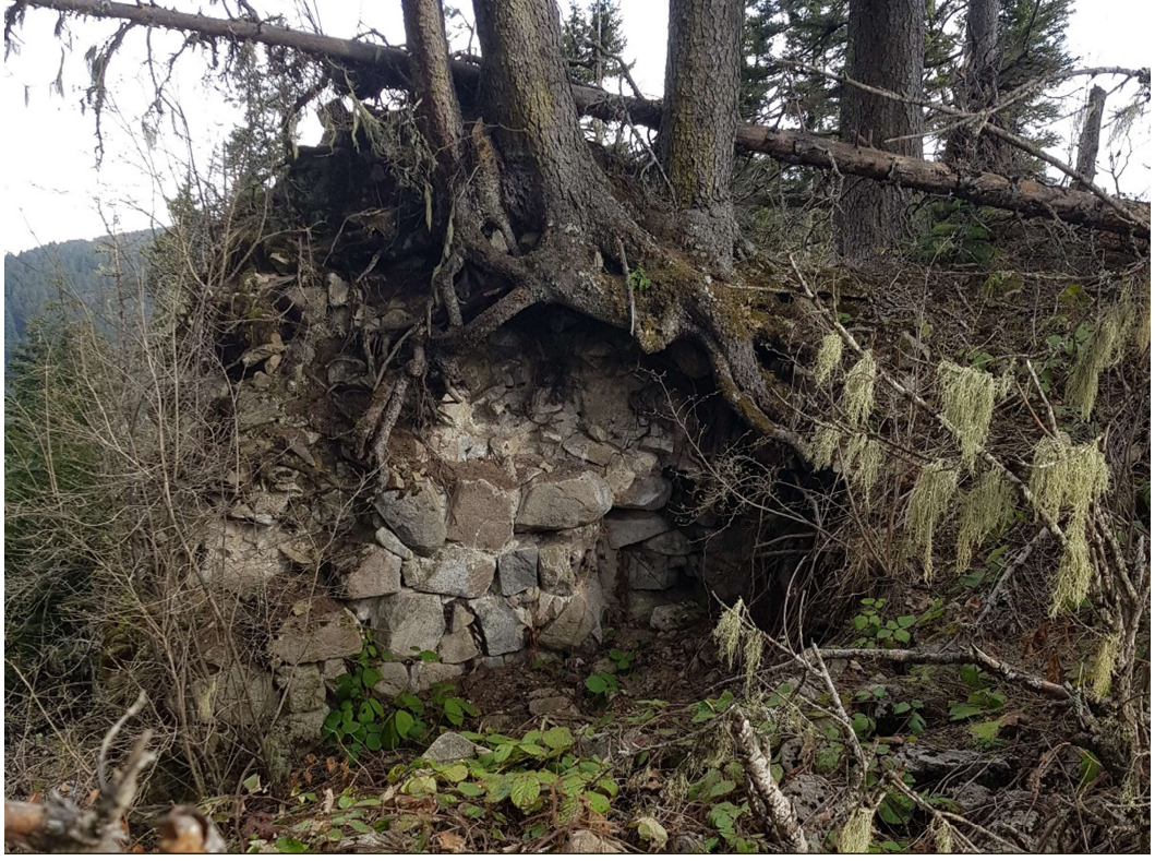
Ek 33: Şahne Gözetleme Kulesi'nin Duvar Kalıntıları
