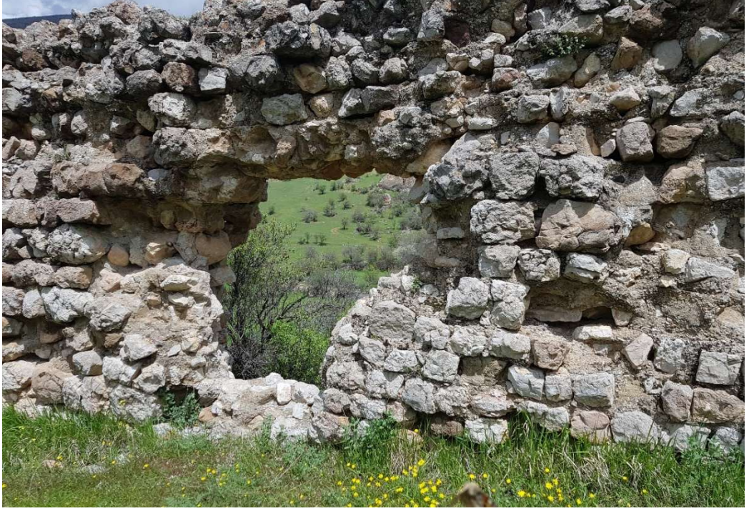
Ek 105: Hacıemirođlu (Avarak) Kalesi Sur Kalıntıları
