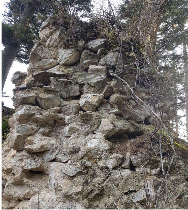
Ek 34: Şahne Gözetleme Kulesi'nin Duvar Kalıntıları
