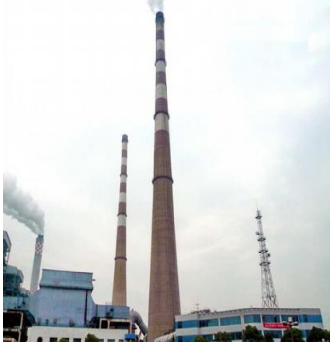
Şekil 1.3. Jiangsu'da (Çin) bulunan güç istasyonunun 240 metrelik betonarme bacası (Zhou vd., 2015)
