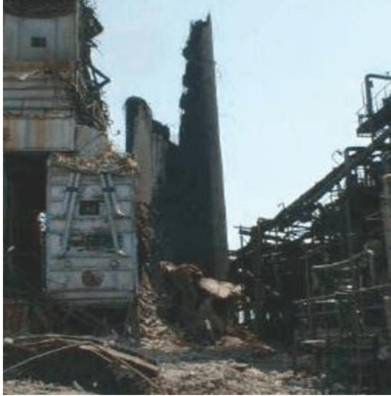
Şekil 1.6. Tüpraş Rafinerisi'nin 115 metrelik yıkılan betonarme bacası (Huang vd., 2004)
