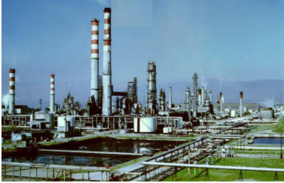
Şekil 1.4. Tüpraş rafinerisinin 115 metrelik betonarme bacası (Huang vd., 2004)
