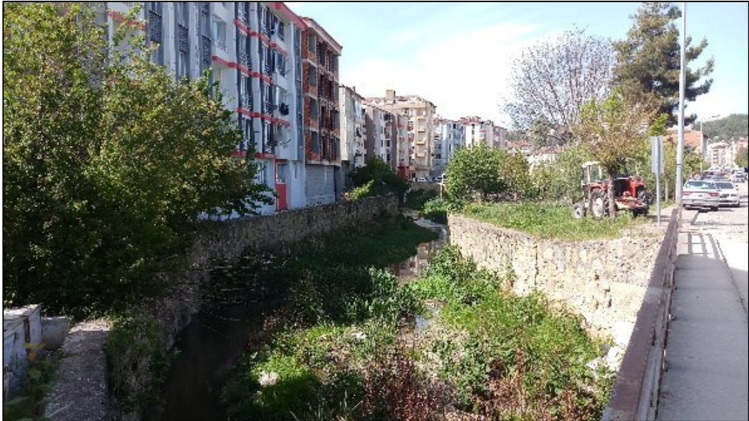
Şekil 3.17. İcadiye Mahallesi'nde Çayırözü Deresi'nin mansap kısmı yakınlarında akarsu yatađında alüvyal malzeme ve bitkiler bulunmaktadır.
