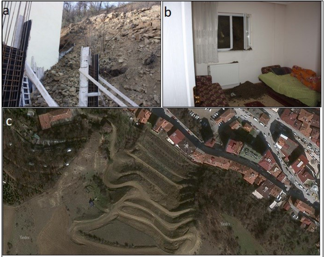
Şekil 3.8. Heyelanların araştırma sahasındaki yerleşim alanlarında da yıkıcı etkileri görülmektedir. a) İmaret Mahallesi Kazım Paşa Caddesi’nde yıkılan istinat duvarı ve toprak kayması. b) İmaret Mahallesi Kazım Paşa Caddesi’nde heyelan sonucu toprağın girdiği ev. Fotolar: Özgür Uyaroğlu c) Kazım Paşa Caddesi Heyelanı’nda yapılan teraslama çalışmasının uydu görüntüsü. Kaynak: http://www.yandex.com/harita
