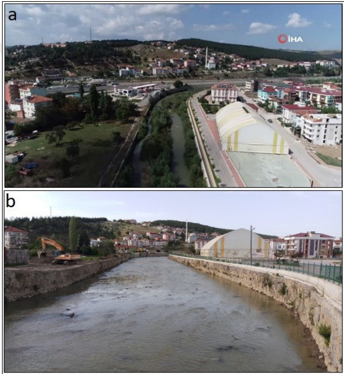
Şekil 3.20. Zaman içerisinde alüvyal malzeme ile kaplanan Tersakan Çayı yatağının şehir içinde kalan bölümünde temizlik çalışması yapılmıştır. a) 31 Ağustos 2019 tarihinde ilçe merkezinde Tersakan Çayı yatağı ( Drone çekim).Kaynak: İhlas Haber Ajansı b) 2020 yılı nisan ayında Tersakan Çayı yatağında DSİ 7. Bölge Müdürlüğü tarafından temizlik çalışması yapılmıştır (Foto: 12 Mayıs 2020).
