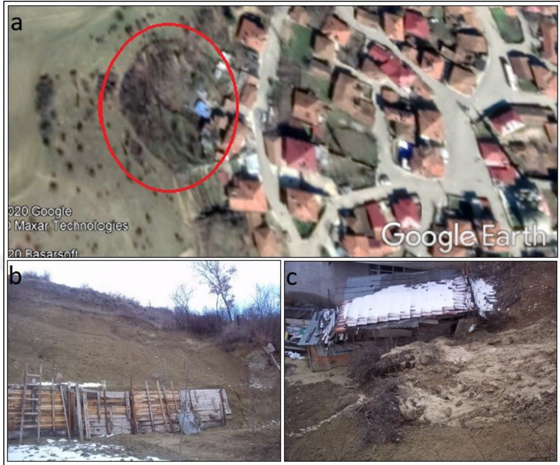
Şekil 3.9. Boyalıca Mahallesi'nde yerleşim alanına ulaşmış bir heyelan bulunmaktadır. a)Dairesel kayma tipi heyelan olan Boyalıca Mahallesi heyelanı yerleşim alanına kadar ulaşmıştır. b) Vatandaşlar kendi olanakları ile heyelanı engellemeye çalışmışlardır. b)Boyalıca heyelanının geldiği durum. Kaynak: AFAD Samsun İl Müdürlüğü, 2012
