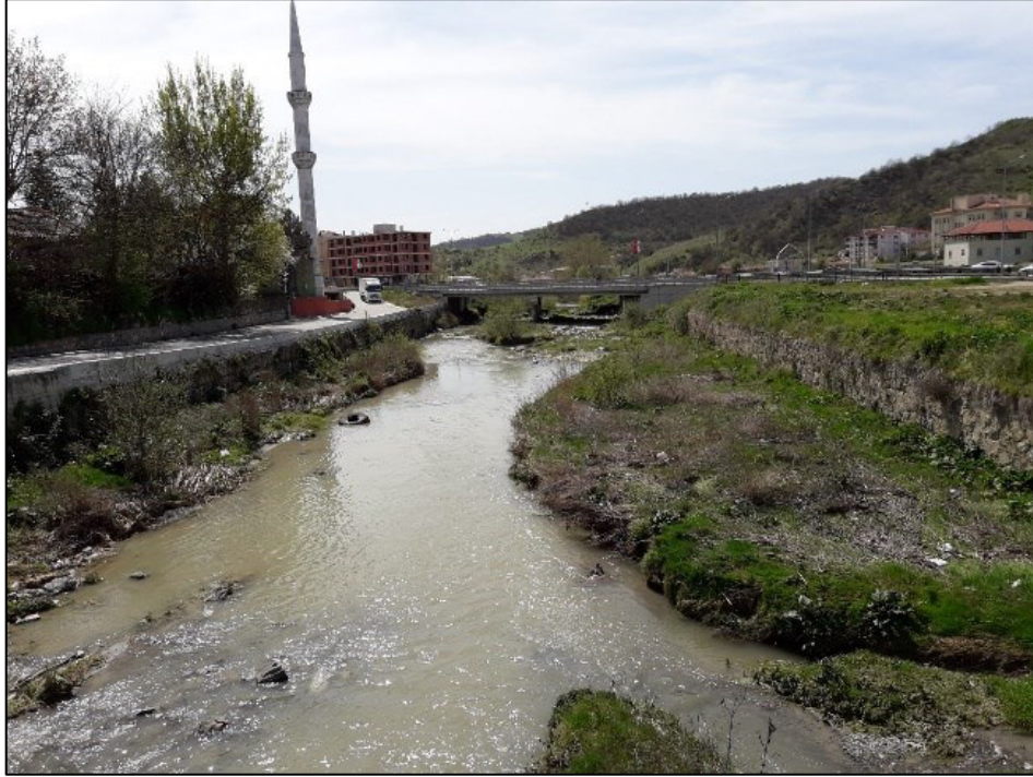
Şekil 2.58. Havza ilçe merkezi Tersakan Çayı kenarında yer almaktadır.
