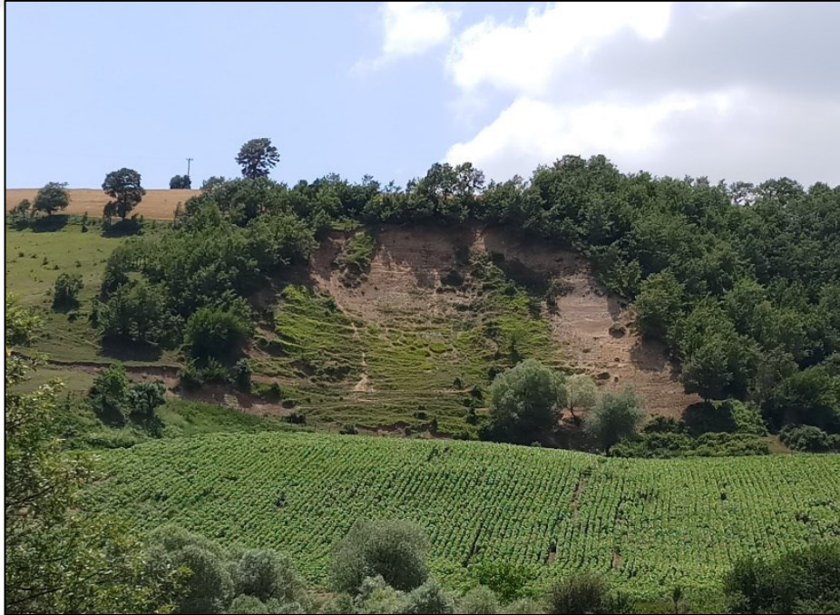
Şekil 3.11. Yağbasan Tepesi yakınlarında yol yarmasında gelişen bir heyelan bulunmaktadır.
