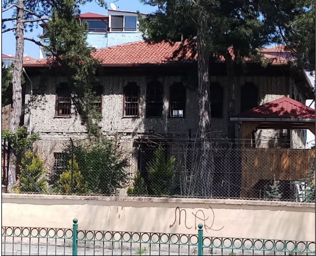
Şekil 2.105. Bahçelievler Mahallesi'nde yığma tuğlalı geleneksel mimari örnekleri bulunmaktadır.
