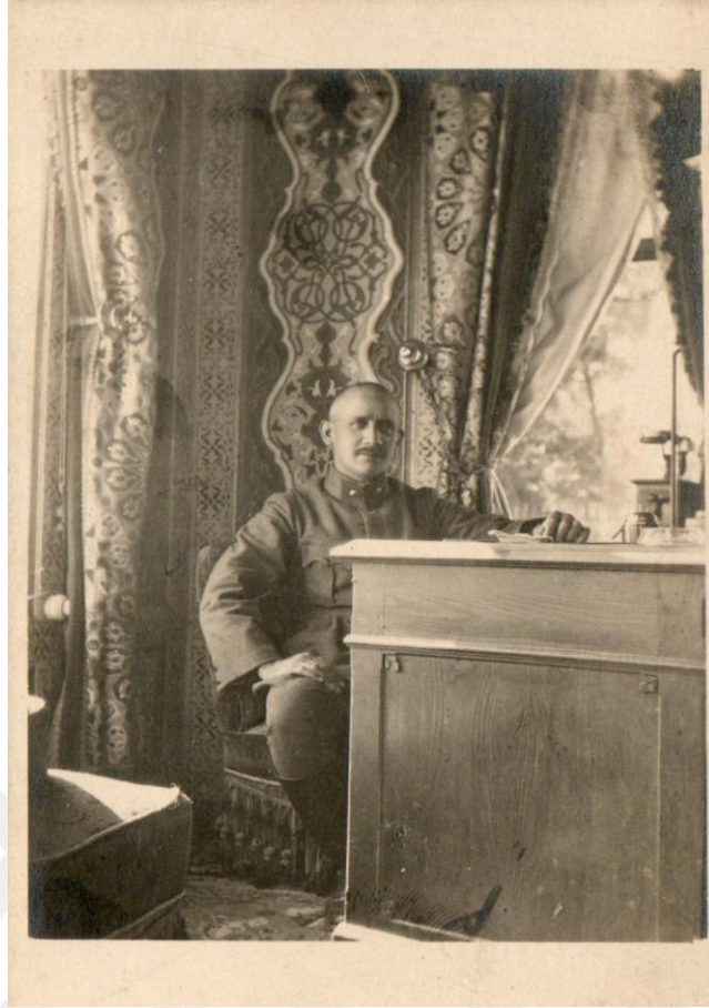
Şekil 3.7. Şükrü Naili Paşa Hereke’de (20 Ağustos 1923)
