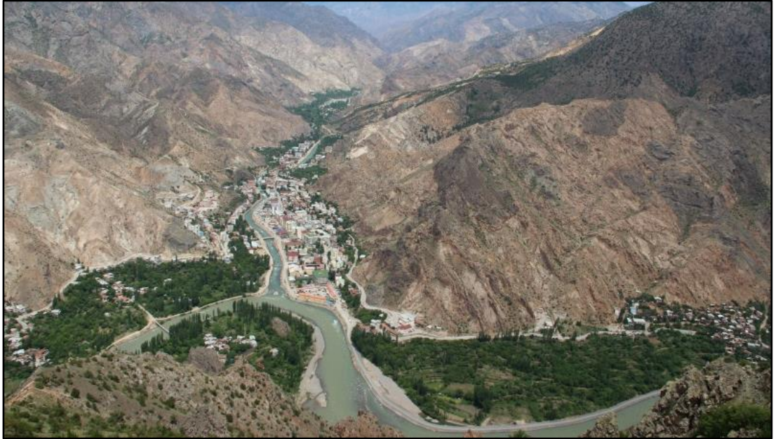
Şekil 3.5. Alüvyon saha, güneyden Yusufeli İlçesine bakış
