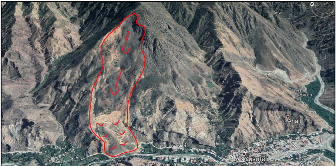
Şekil 4.28. Çalışma sahasında Heyelanın (Eski) Google Earth görünümü, doğuya bakış
