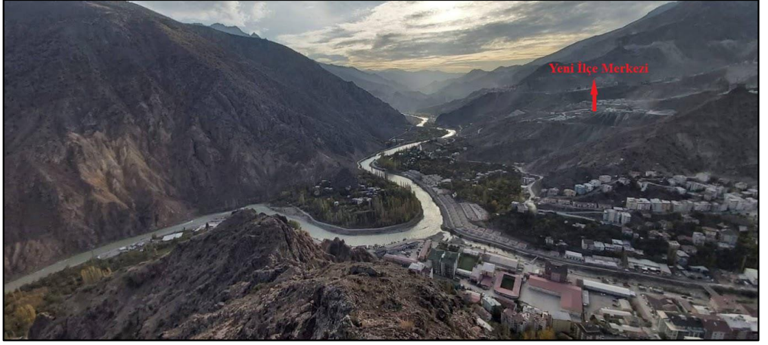
Şekil 3.27. Baraj gölü içinde kalacak olan Yusufeli İlçesi ve yeni İlçe merkezinden bir görünüm Kaynak: https://www.yusufeli.bel.tr/
