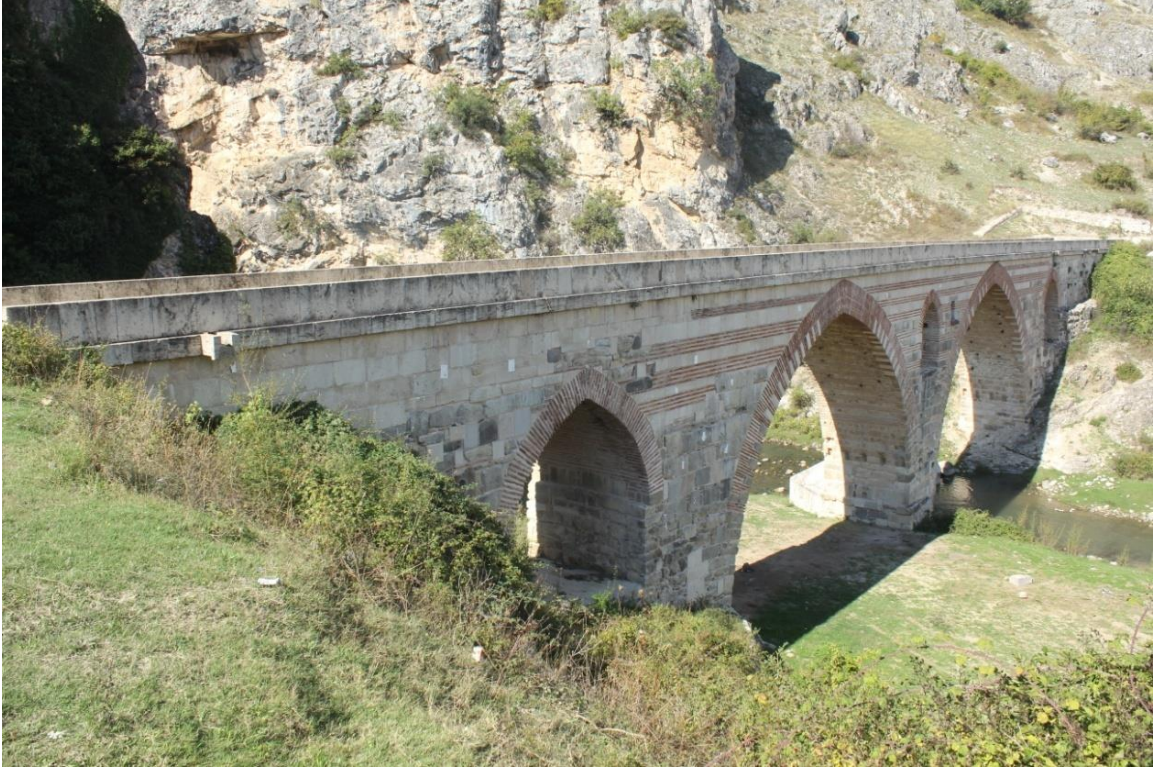
Şekil 12: Tekkekıran Mahallesi, Kurt Köprü
