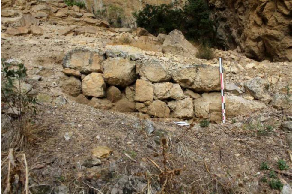
Şekil 8: Kaplancık Mahallesi, Kanyon Bedesten Mevkii, istinat duvarı
