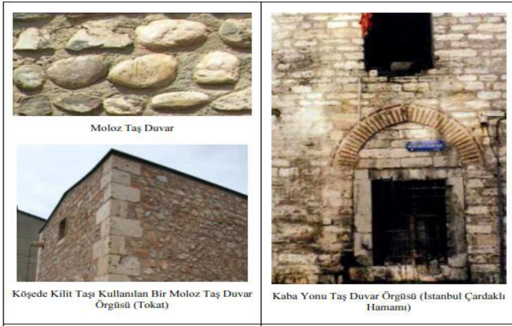
Şekil 2.5. Taş Duvar Örgü Türleri-1 (MEB, 2013).
