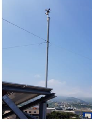
Şekil 3.5. Bu çalışmada kullanılan PV sisteminde ki VSN800-14 hava istasyonuna ait bir resim.
