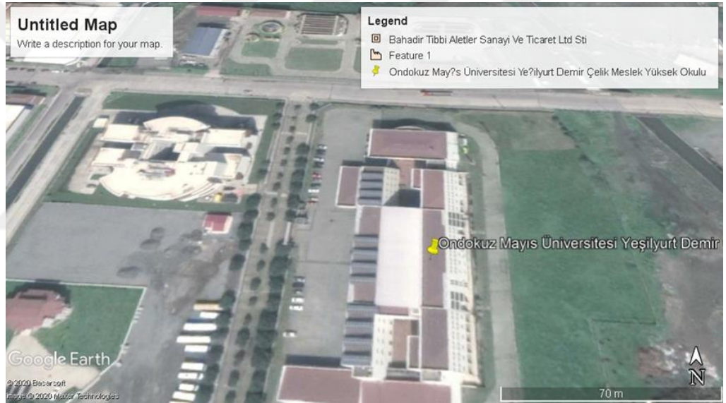
Şekil 3.6. Kampüs binasını ve binanın çatısına kurulan FV sisteminin gösterilmesi.
