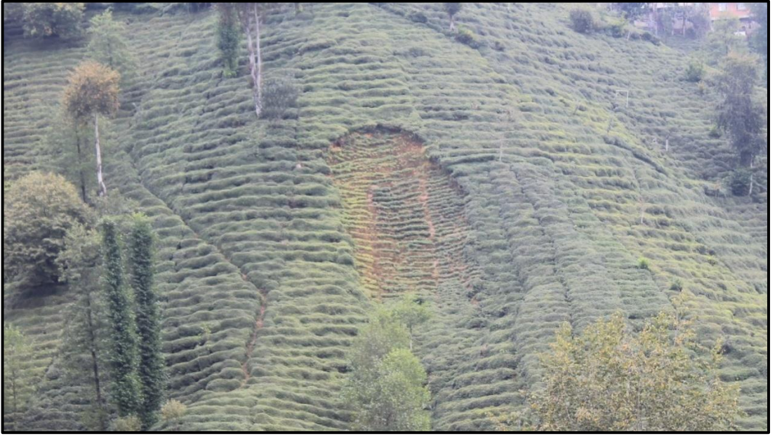
Şekil 3.28. Plan ve profil yamaç eğriselliği dış bükey olan bir yamaçtan heyelan görüntüsü (Kızıltoprak Mahallesi, Kalkandere)
