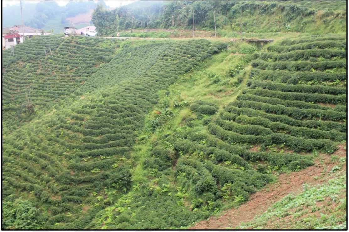
Şekil 3.40. Yokuşlu-Yeniköy (Kalkandere) yerleşmeleri arasındaki yolun altında gerçekleşmiş bir heyelan görüntüsü.
