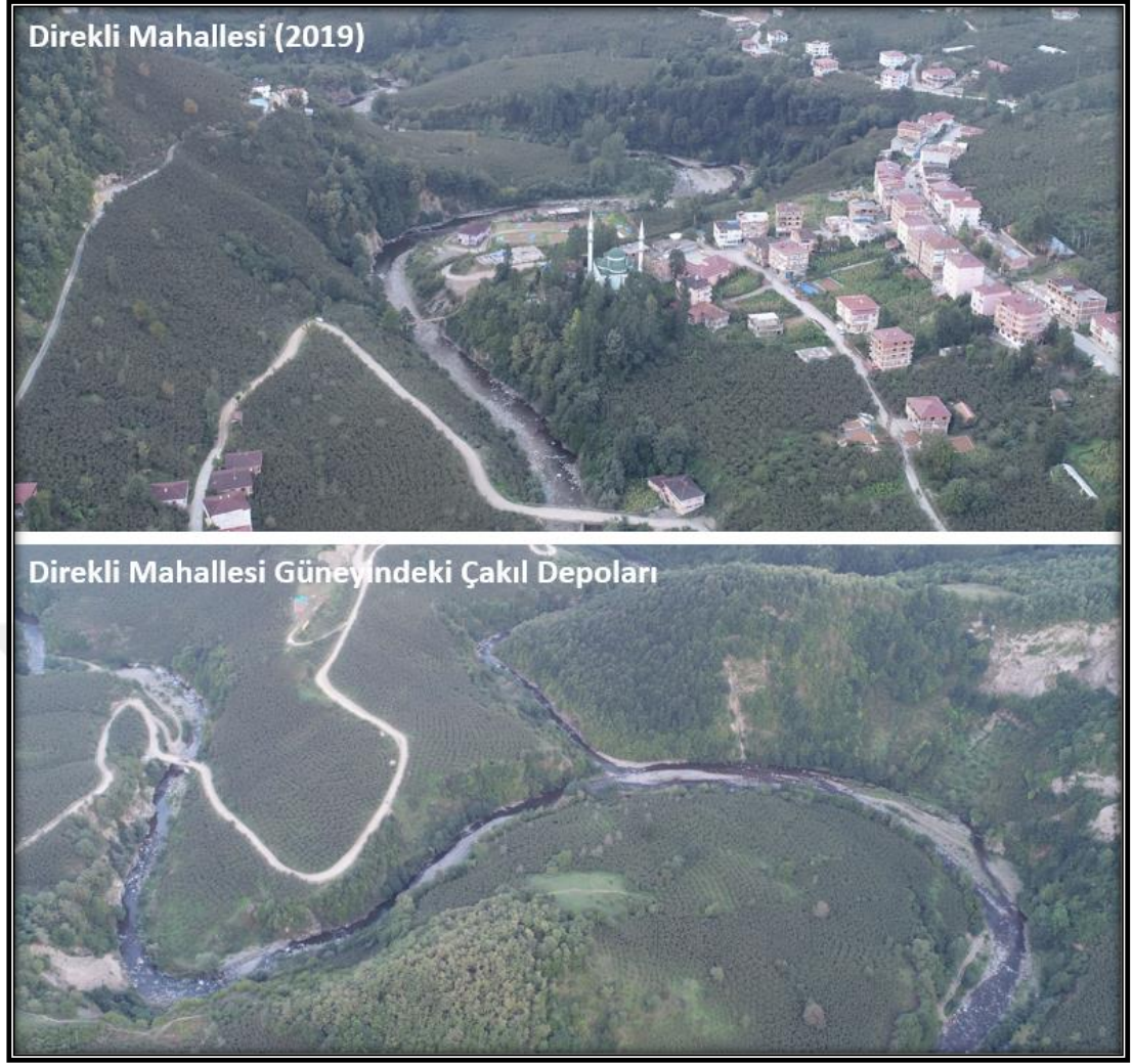
Şekil 5.6. Direkli mahallesi çevresinde yüksek taşkın duyarlılığına sahip yerler bulunmaktadır (2019)
