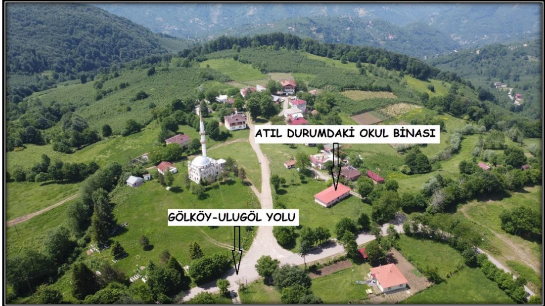
Şekil 5.8. Cihadiye mahallesinde bulunan eğitim yerleşkesi kurulabilecek âtıl durumdaki okul binası ve çevresi (2020)
