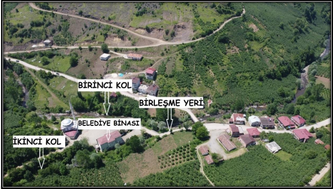
Şekil 5.5. Taşkın duyarlılığının yüksek çıktığı yerlerde yapılan yapılaşmaya örnek (Karahasan-2020)
