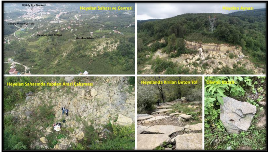
Şekil 4.6. Heyelan sahasından yapılan arazi incelemesi, belirlenen kayaç türleri ve heyelanın beton yolda meydana getirdiği bozulmalardan görüntüler (Sarıca Mahallesi-2019)
