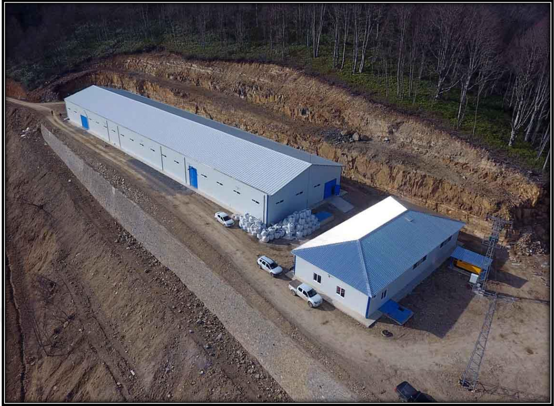
Şekil 4.33. Gölköy ve Gürgentepe ilçelerine içme suyu sağlayan arıtma tesisi (2019)
