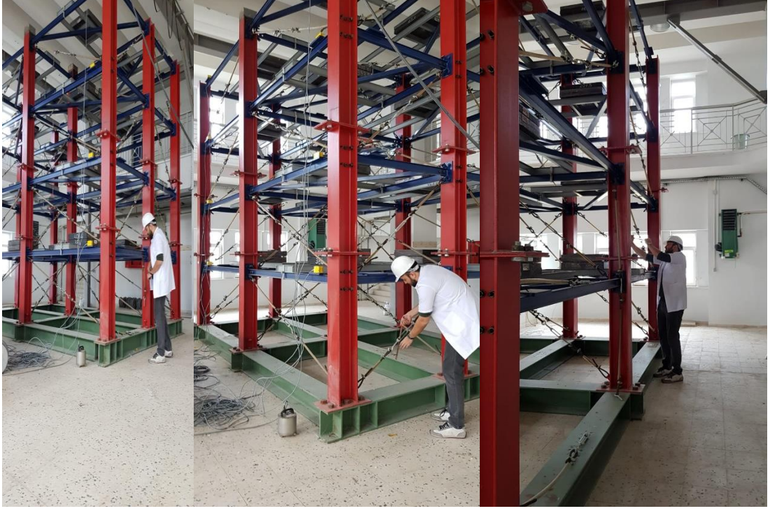
Şekil 4.31. Kablo elemanların sökülmesi
