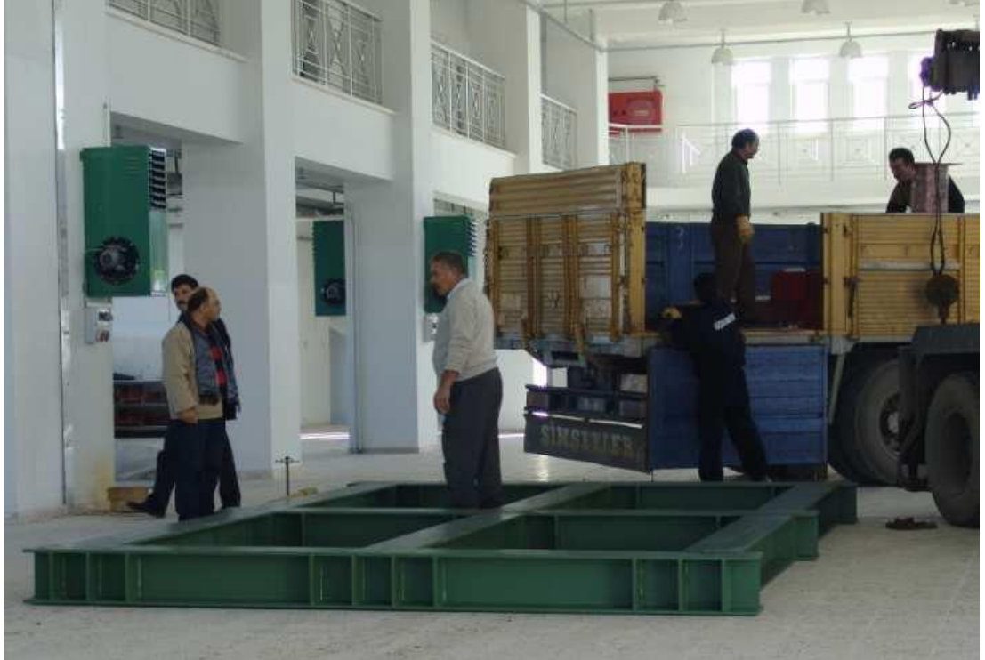
Şekil 3.1. Temel profillerinin (IPG260) yerleştirilmesi ve montajı
