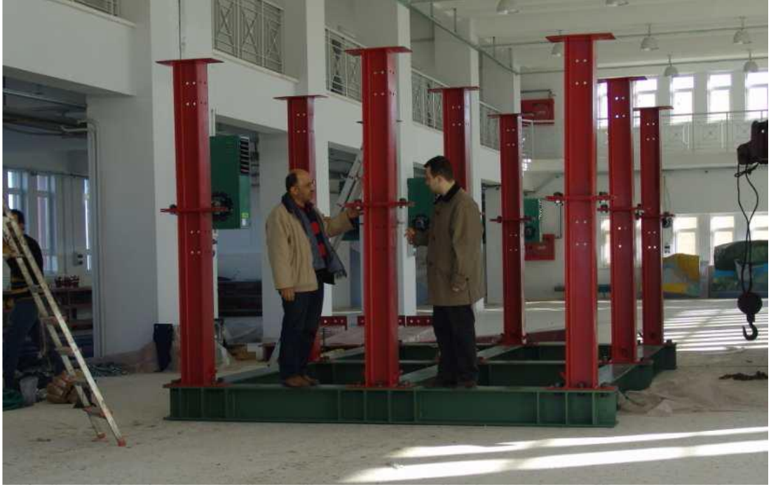
Şekil 3.2. Kolonların (IPG200) temele yerleştirilmesi ve montajı
