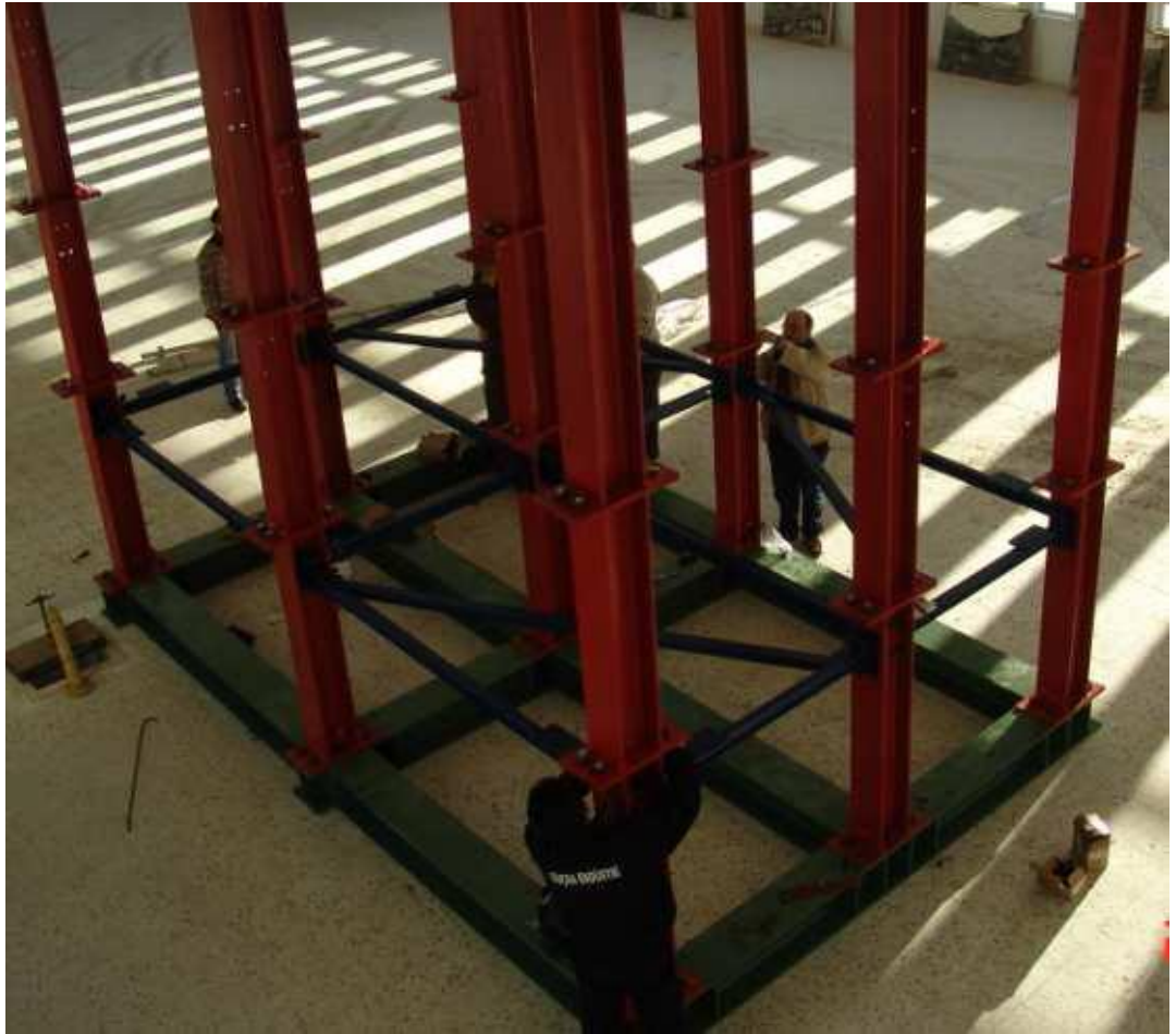
Şekil 3.3. Kirişleri (I80) yerleştirilmesi ve montajı
