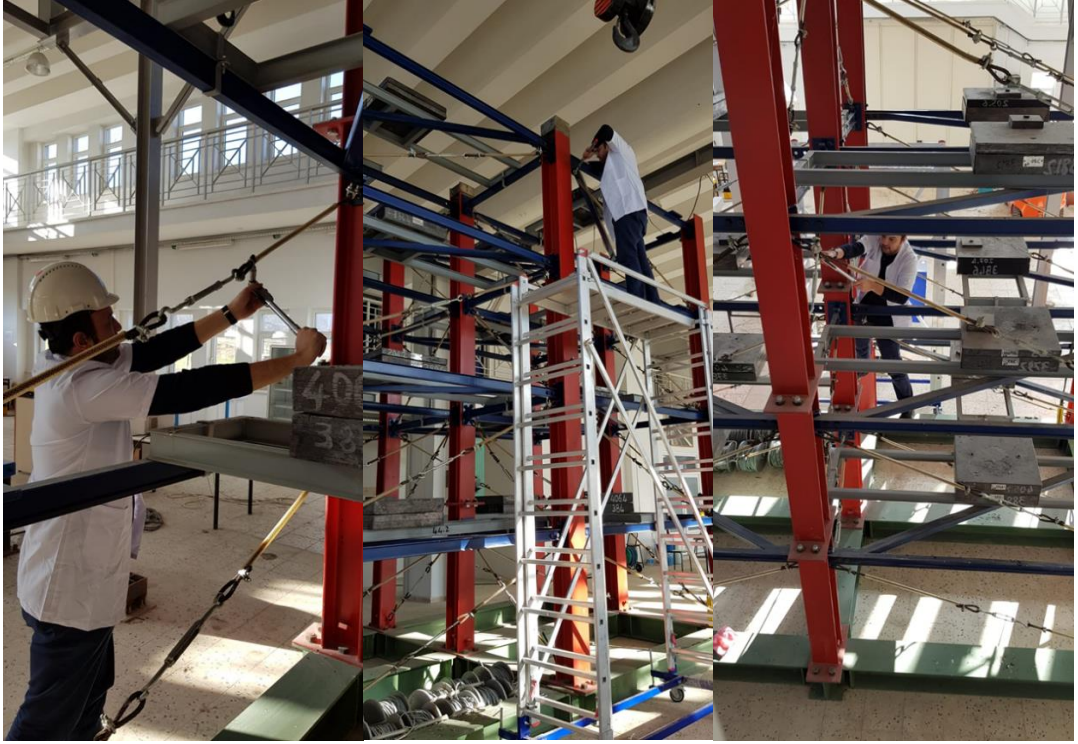
Şekil 4.3. Çelik deney yapısı bağlantı elemanlarının tork anahtarları ile sıkılması ve kontrolü
