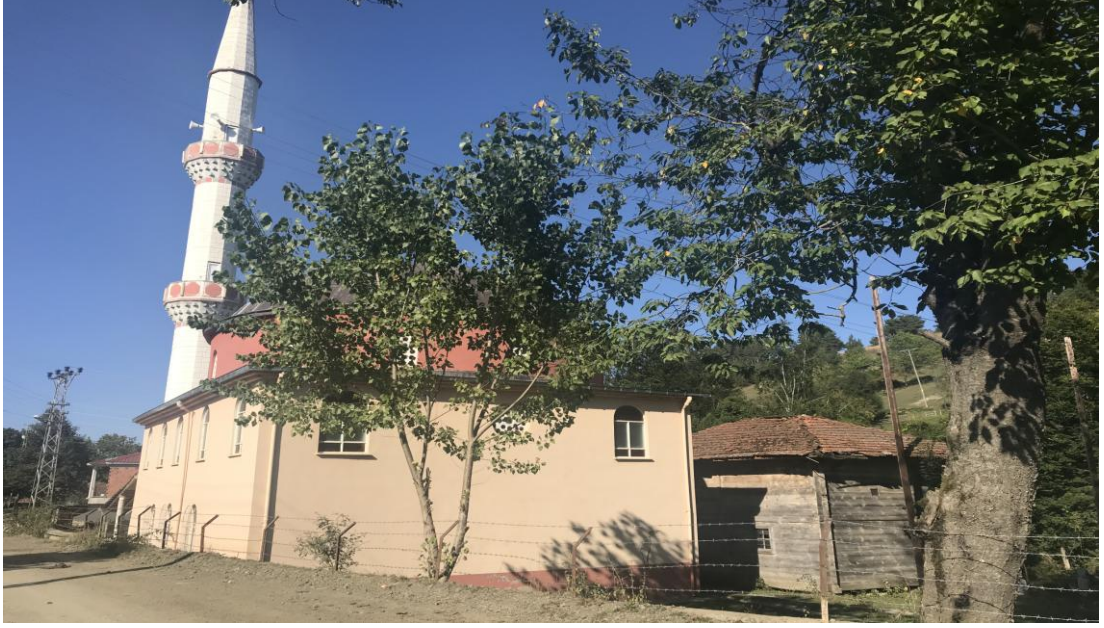
Şekil 4. 30. Şirinköy Mahallesi'nde bulunan yeni(betonarme) ve eski(ahşap) cami
