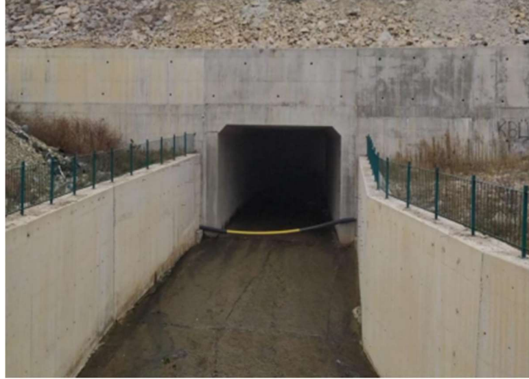
Şekil 3.2. Kutu kesitli betonarme menfez
