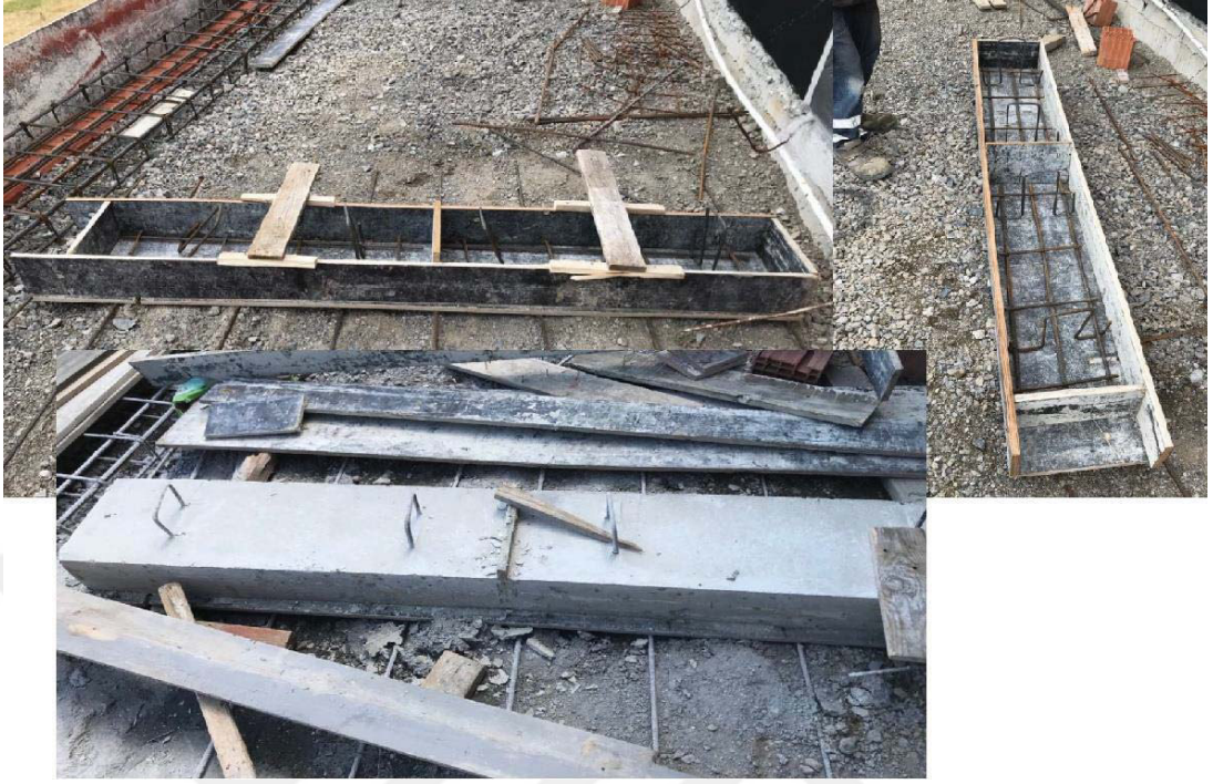
Şekil 3.9. Model çelik köprü betonarme mesnet yapılması kalıp-demir-beton
