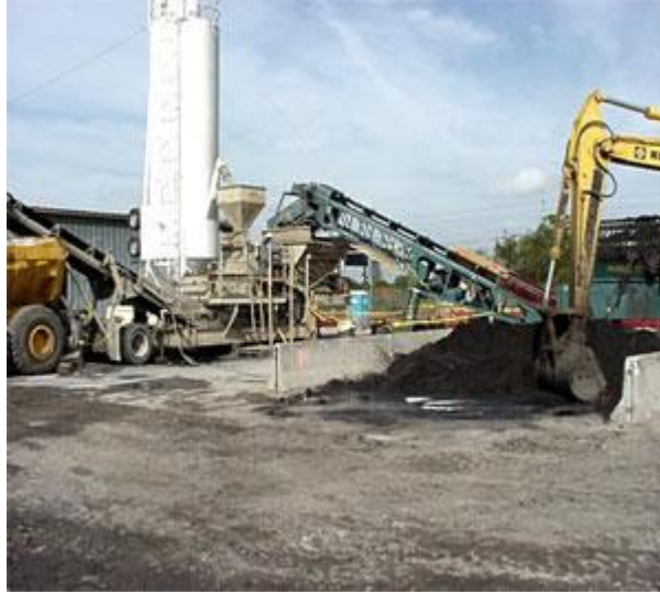
Şekil 2.7. Arazi dışı (Ex-Situ) karıştırma işlemi (Barnett, et al., 2009)
