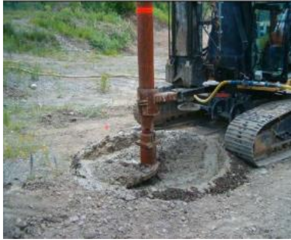
Şekil 2.6. Arazi içi (In-Situ) karıştırma işlemi (Barnett, et al., 2009)
