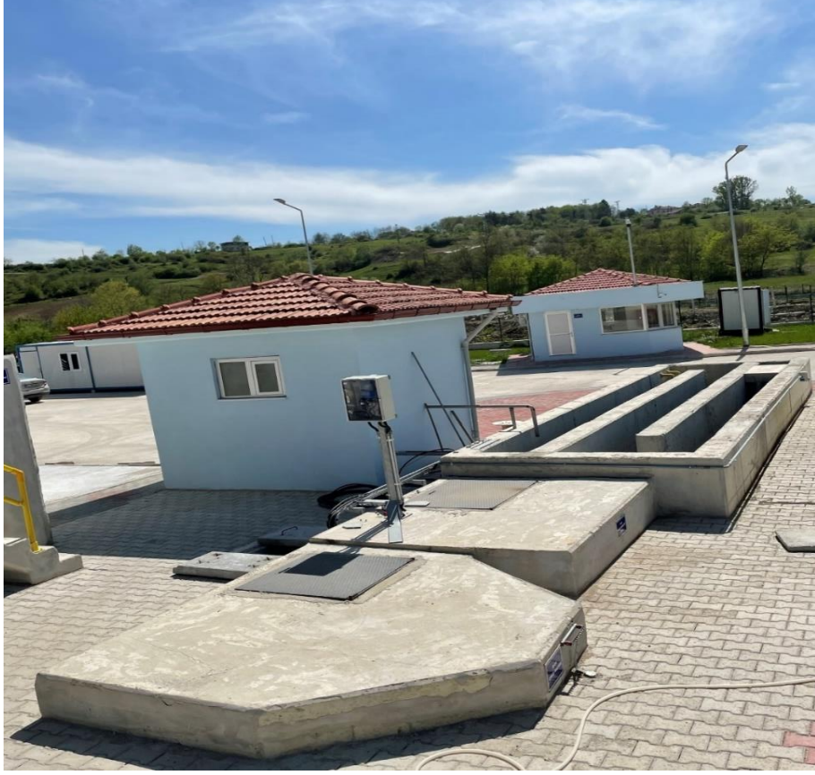
Şekil 3.19. Klor Binası ve Klor Temas Tankı (Kavak Atık Su Arıtma Tesisi)
