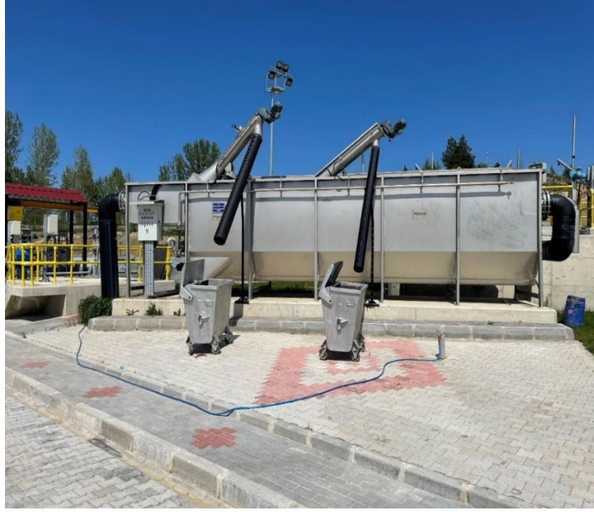
Şekil 3.6. Kombine İnce Izgara ve Kum ve Yağ Tutucu Ünitesi
