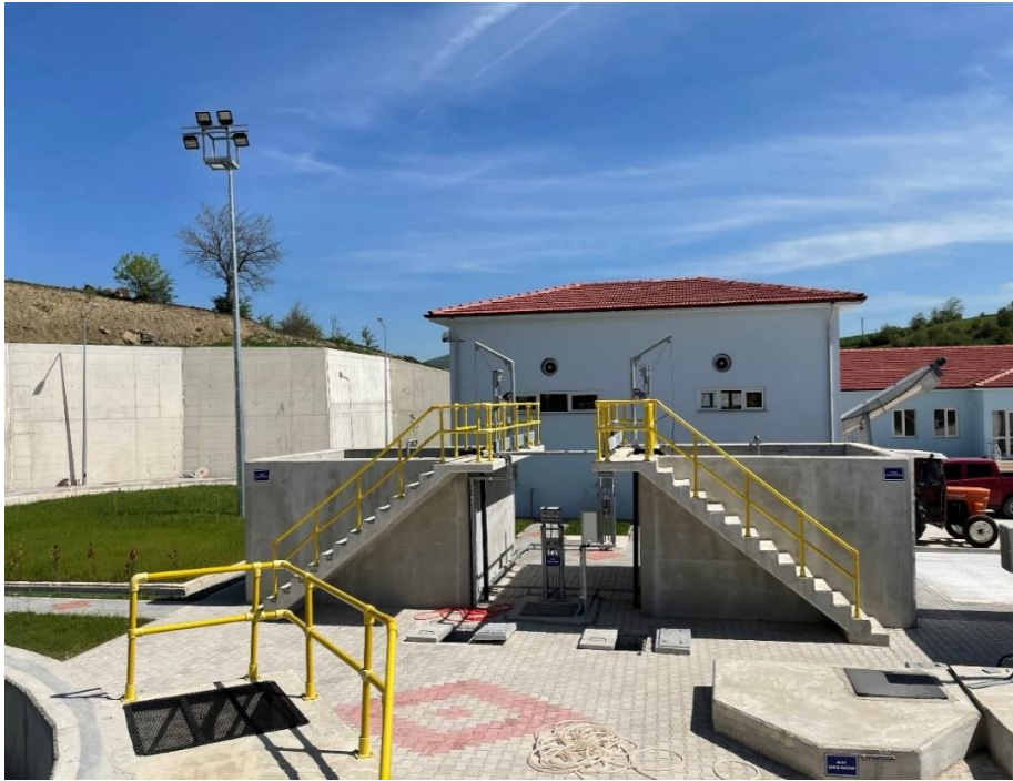
Şekil 3.17. Çamur Depolama Tankları (Kavak Atık Su Arıtma Tesisi)
