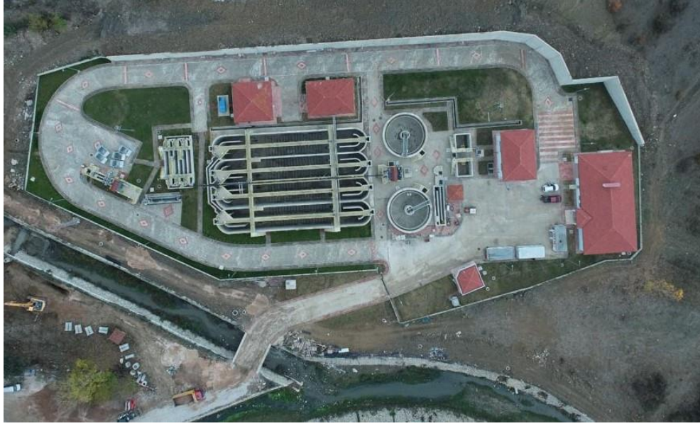
Şekil 3.1. Kavak (SAMSUN) Atık su Arıtma Tesisi
