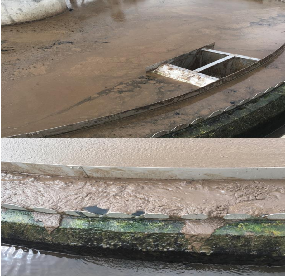
Şekil 2.10. Atık su Arıtma Tesisi Havalandırma Ünitelerinde Oluşan Çamur Kabarması Görüntüleri
