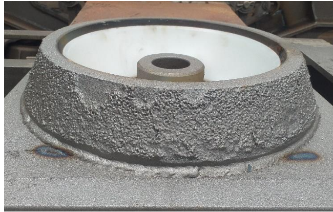
Şekil 2.17. Korozif aşınmaya uğramış bir boji alt göbeği
