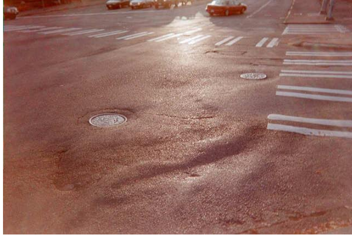
Şekil 2.7. Kaplamada ondülasyon ve yığılma (Bisantiye, 2021)
