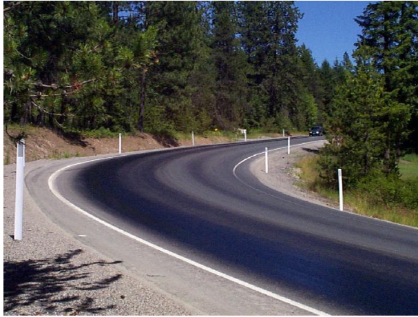
Şekil 2.11. Kaplamada kuma-terleme (PavementInteractive, 2021a)
