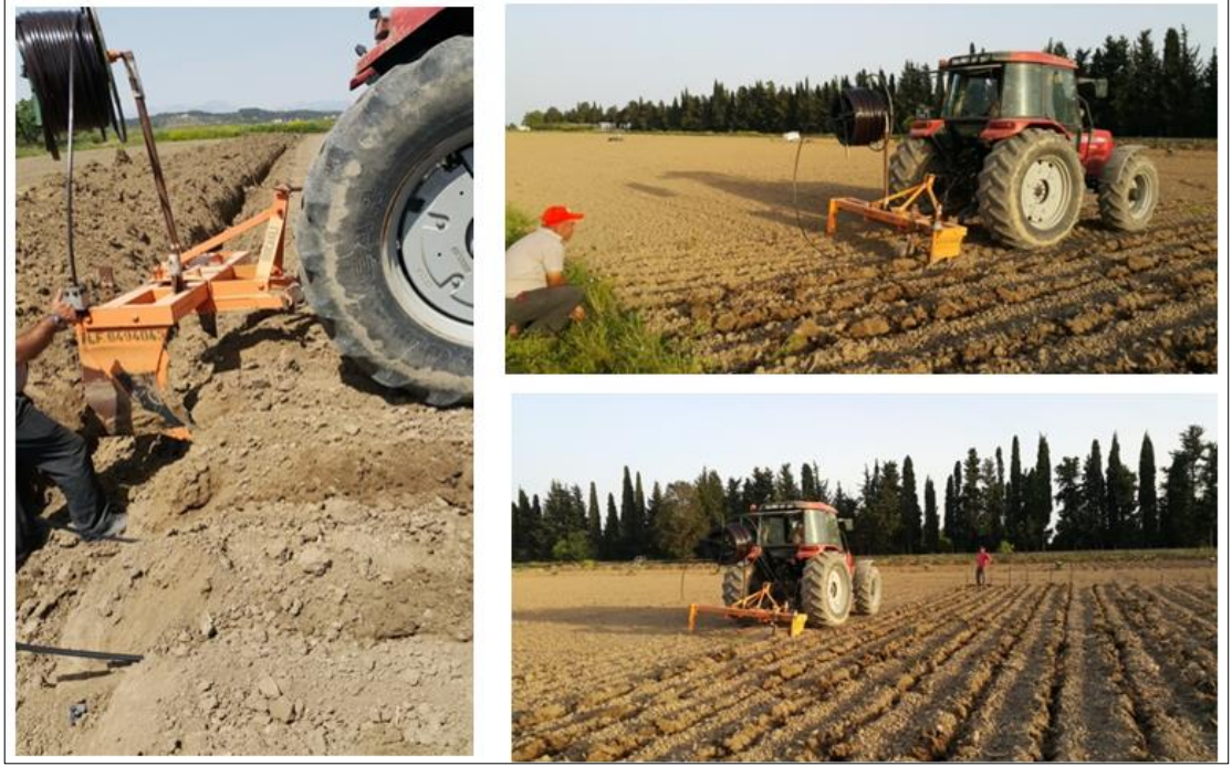
Şekil 3.3. Deneme alanına yüzeyaltı damla sulama sisteminin kurulumu
