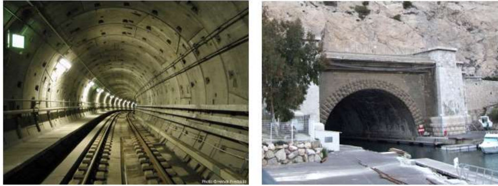
Şekil 3.4. Metro ve kanal tünellerinden örnek bir görünüm
