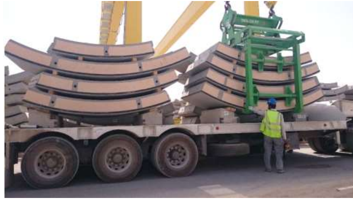
Şekil 5.1. Taşıyıcıya betonarme prekast segmentlerin yüklenmesi
