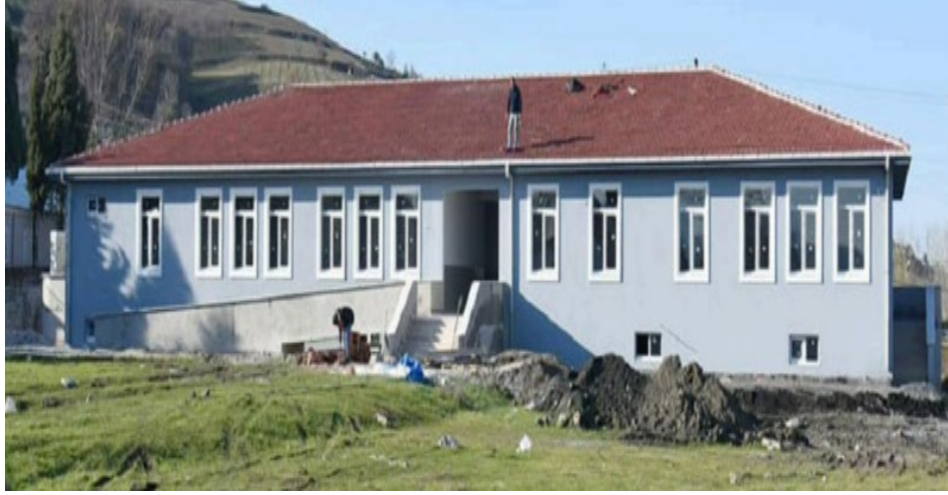
Şekil 2.5. Tekkeköy Belediyesi Okul İnşaatı
