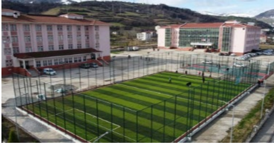
Şekil 2.9-Tekkek y Belediyesi Okul Spor Sahası İnşaatı
