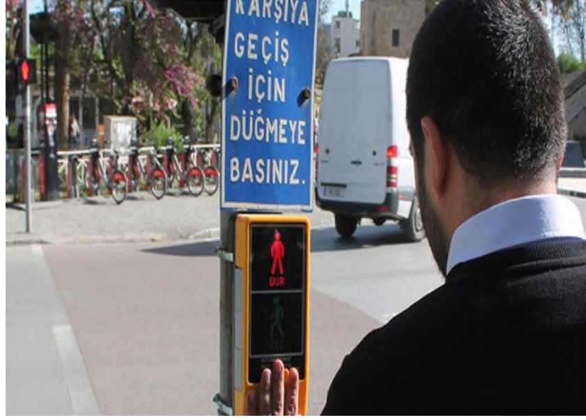
Şekil 3.13. Yaya Uyarmalı Sinyalizasyon Sistemi Uygulaması ve Butonu
