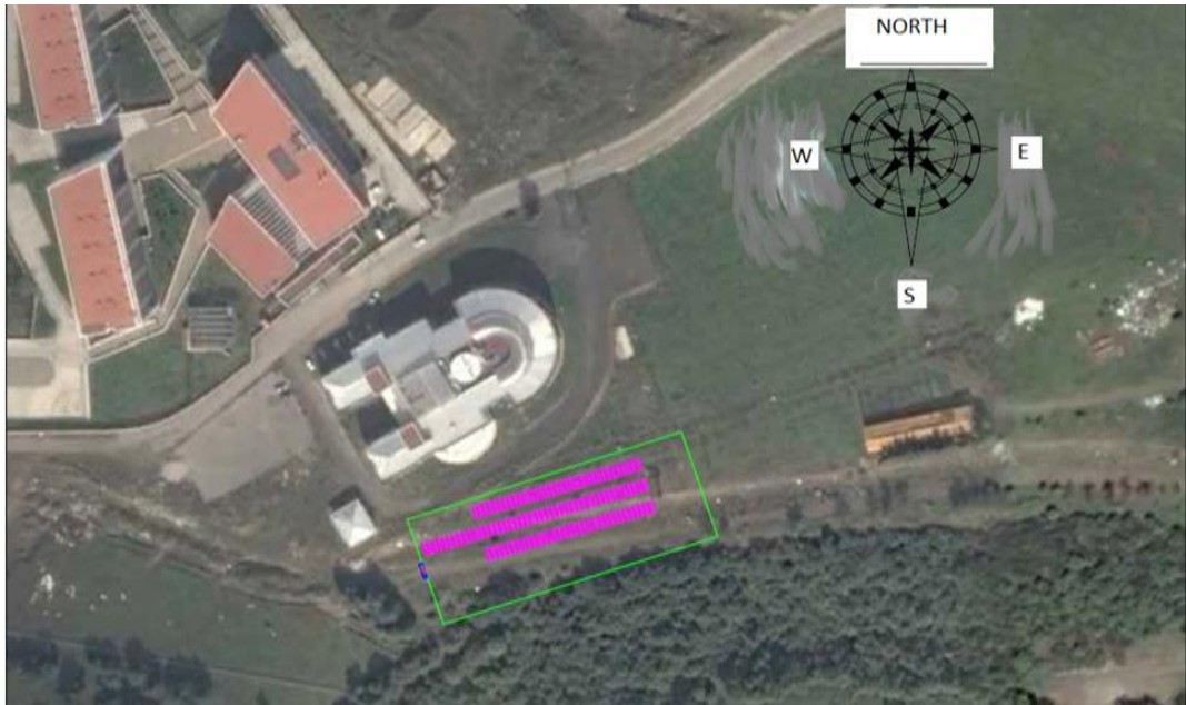
Şekil 3.5. Santralin bulunduğu alana ait uydu görüntüsü
