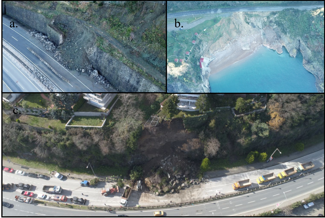
Şekil 5.22. Araştırma sahasındaki (güncel) heyelanlara örnekler: a. Karadeniz sahil yolunda meydana gelen heyelan (Keşap), b. Eski sahil yolunda meydana gelen heyelan ve yolun bir kısmının göçmesi (Ulu Burun plajı-Keşap), c. Altınordu ilçe merkezinde, Karadeniz sahil yolunda meydana gelen heyelan (URL-3, 2020).
