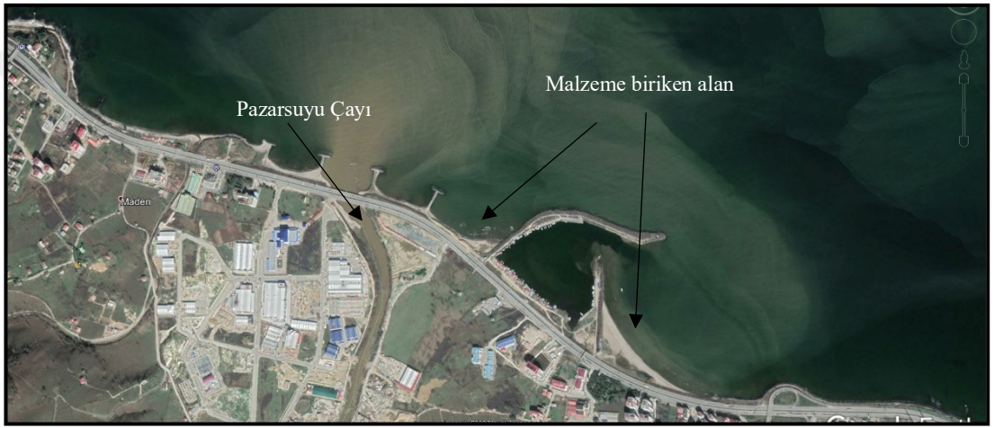
Şekil 7.2. Pazarsuyu Çayı'nın getirdiği malzemelerin dalga ve akıntılarla kıyı yapılarının kenar kısımlarında birikmesi
