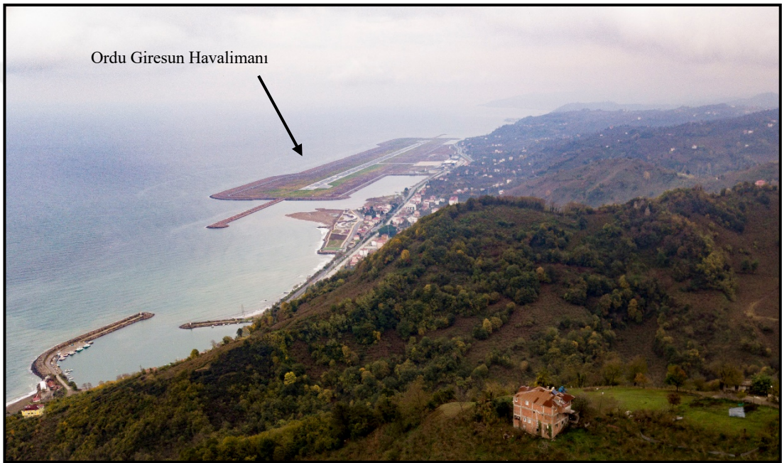
Şekil 5.5. Ordu Giresun Havalimanı (28 Kasım 2019)
