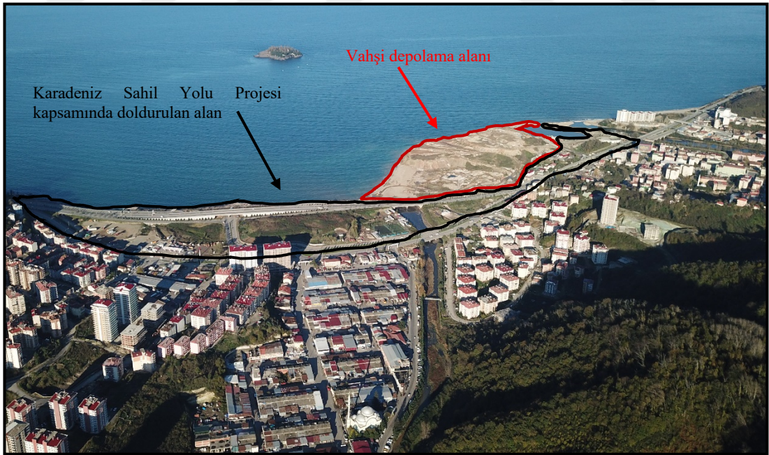
Şekil 5.4. Boğacak ve Aksu Çayı ağzında yer alan vahşi depolama alanı (kırmızı çizgi) ve gerisinde Karadeniz Sahil Yolu Projesi'yle doldurulan alan (siyah çizgi)
