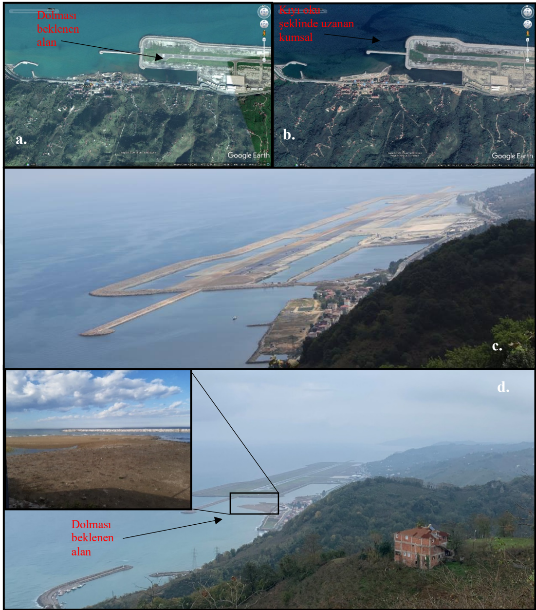
Şekil 7.3. Ordu Giresun Havalimanı batısında, dalga ve akıntılarla dolması beklenen alan (a. Google Earth görüntüsü: 5 Nisan 2018, b. Google Earth görüntüsü: 13 Ekim 2019, c. 28 Ağustos 2014, d: 28 Aralık 2019)
