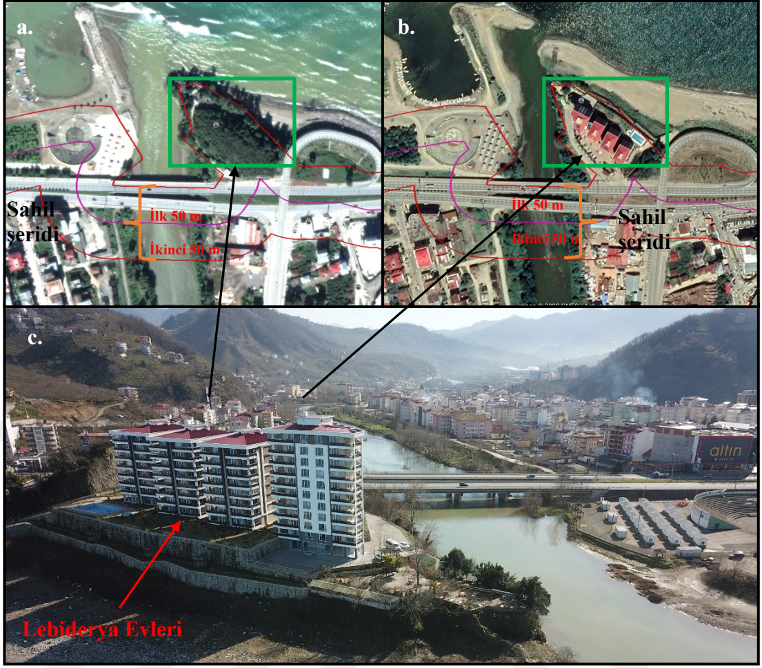
Şekil 6.9. Sahil şeridinin ilk 50 m içerisine inşa edilen site (Aksu Mahallesi/Giresun): a. 2011 yılı Google Earth görüntüsü, b. 2020 yılı Google Earth Görüntüsü, c. Bahse konu olan alanın gerçek görüntüsü
