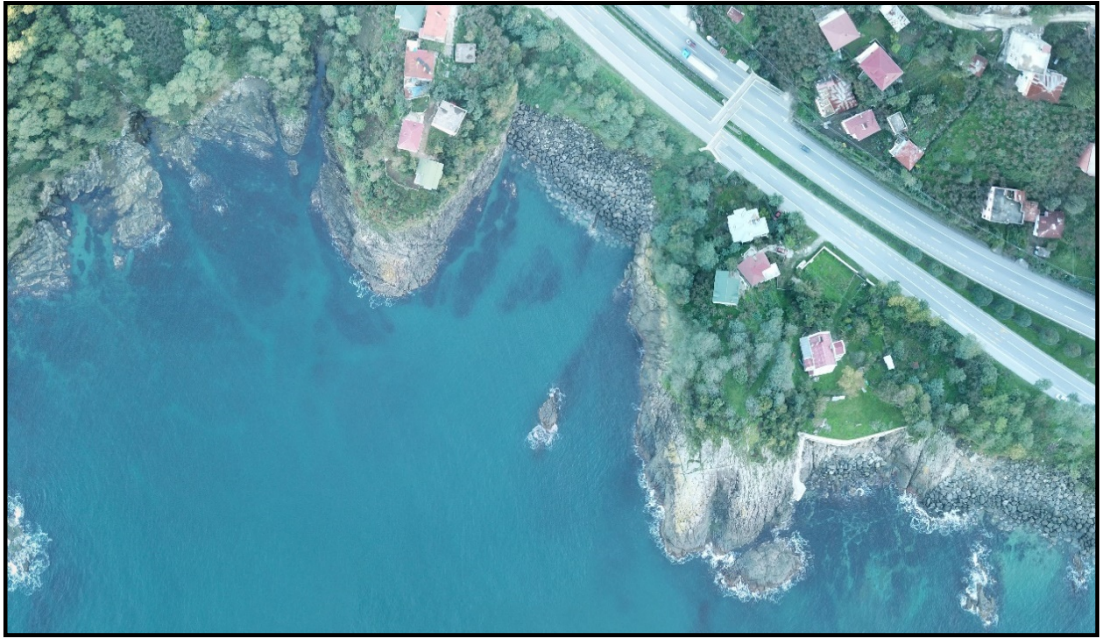
Şekil 2.52. Değirmenağzı Köyü kıyılarındaki falezler (Keşap/Giresun-28 Ekim 2019)
