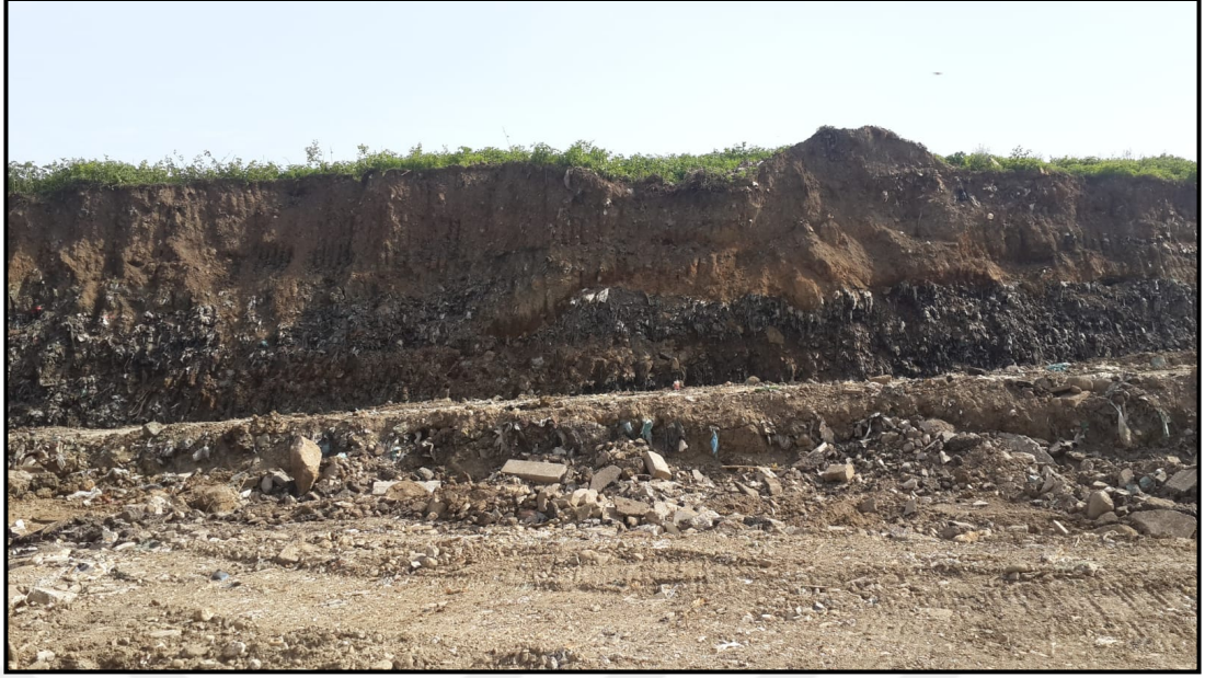
Şekil 6.2. Akarsu vadilerinde katı atıkların depolanması (Boğacak Deresi)
