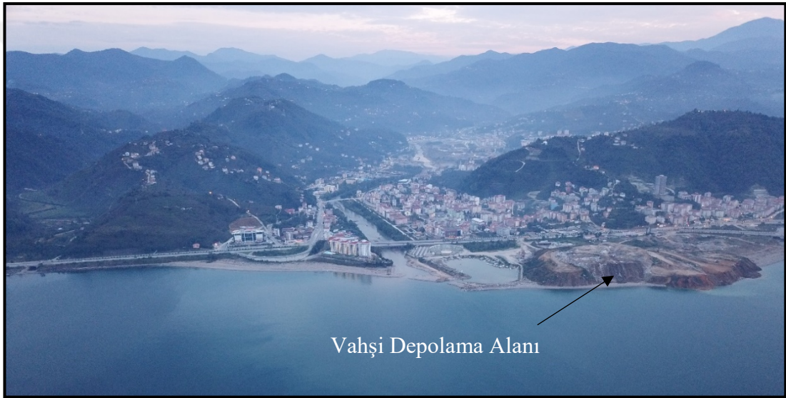
Şekil 6.1. Giresun Belediyesi evsel nitelikli katı atıkların vahşi depolama alanı (22.10.2017)
