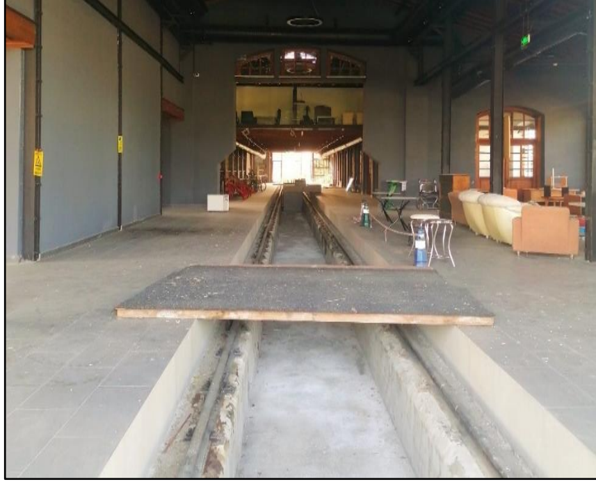
Şekil 5.85. Demiryolu Rayları Restorasyon Öncesi
