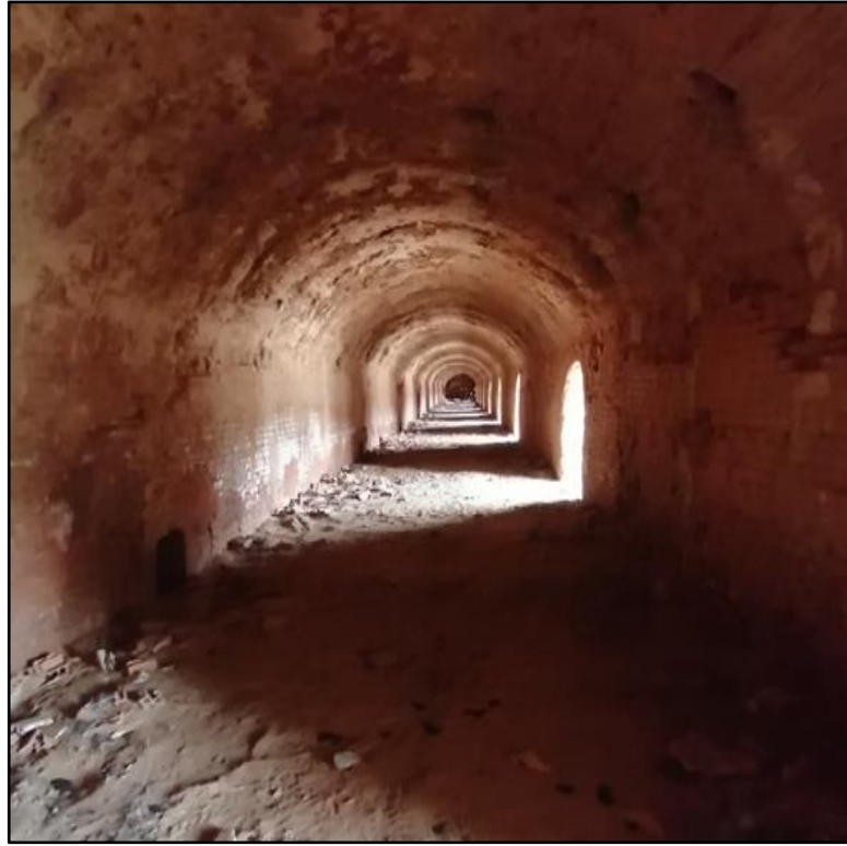
Şekil 5.19. Fabrika İçinde Fırınların Bulunduğu Yapı
