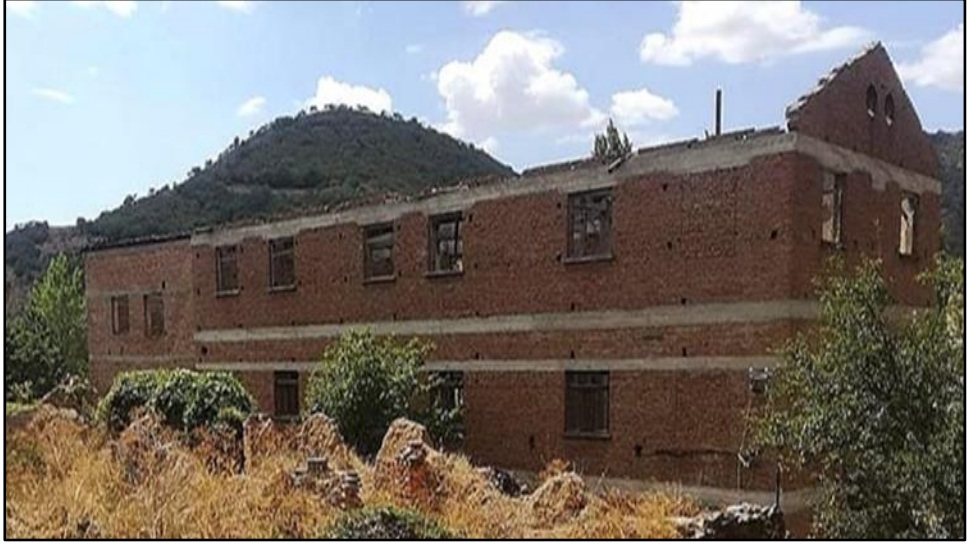
Şekil 5.29. Sekizgöz Un Fabrikası Arka Cephesinin Görünümü
