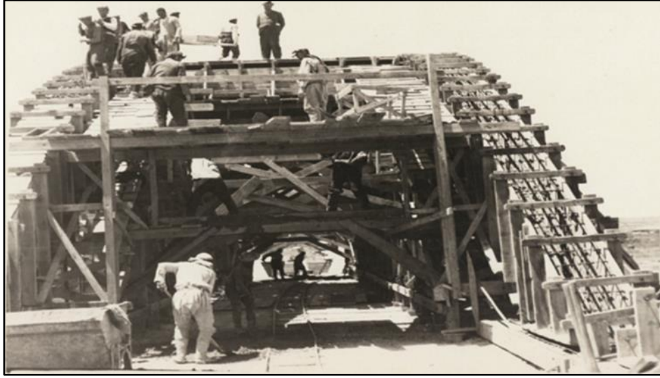
Şekil 5.91. Çetinkaya Köprüsü İnşaatı (Salt Araştırma, 2021)
