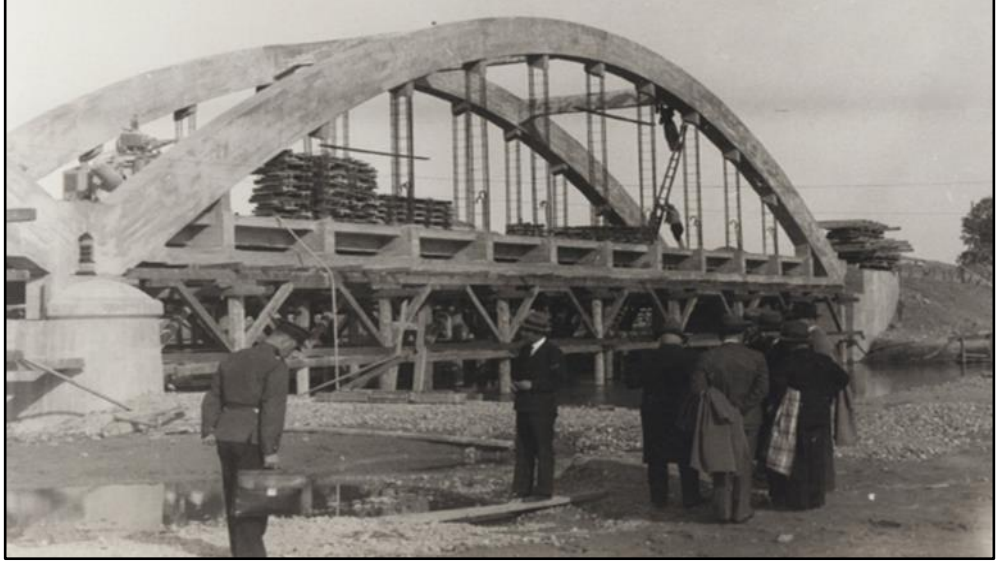
Şekil 5.90. Çetinkaya Köprüsü İnşaatı (Salt Araştırma, 2021)
