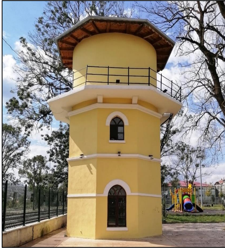
Şekil 5.96. Kavak Şimendifer Su İstasyonu
