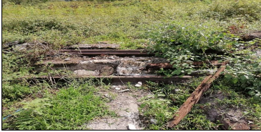
Şekil 5.61. Çarşamba- Samsun Tren Hattı Güzergâhında Bulunan Raylar
