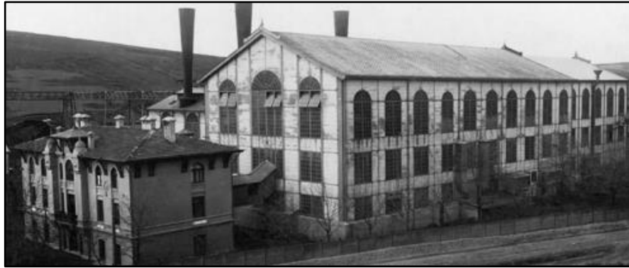
Şekil 4.11. Silahtarağa Elektrik Santrali (Piyade, 2018)
