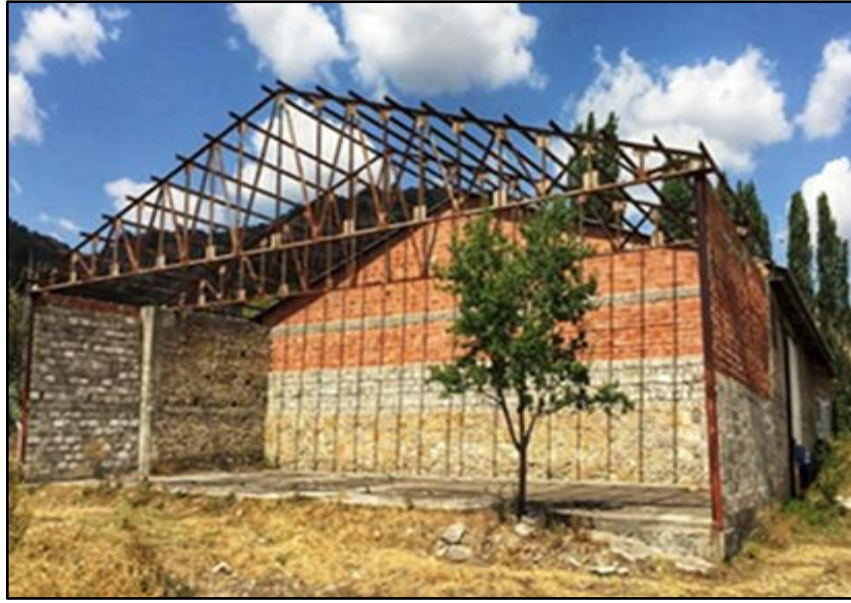
Şekil 5.31. Depo Olarak Kullanılmış Olan Yapı
