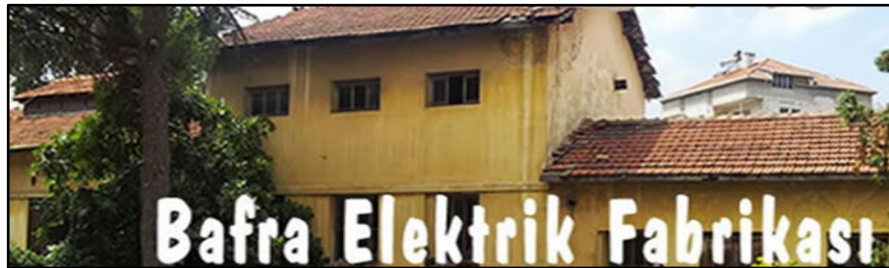
Şekil 5.27. Bafra Elektrik Fabrikası (Yılmaz, 2013)
