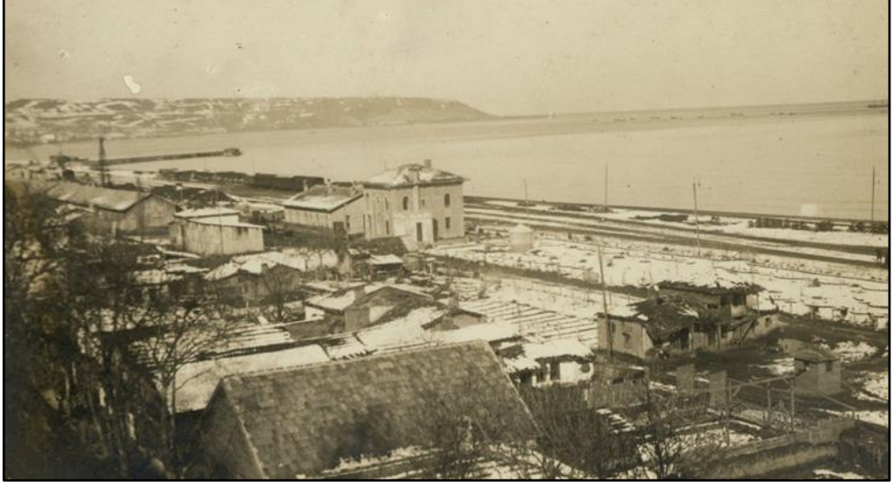
Şekil 5.82. TCDD Lokomotif Bakım Atölyesi (Anonim, 2020)
