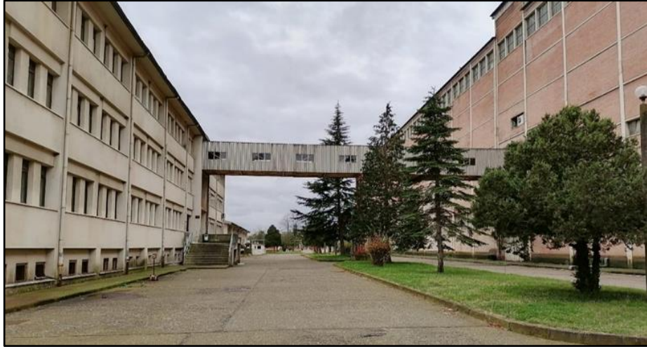
Şekil 5.25. Çarşamba Şeker Fabrikası'nın İdari Bölümü ve Fabrika Yapısı
