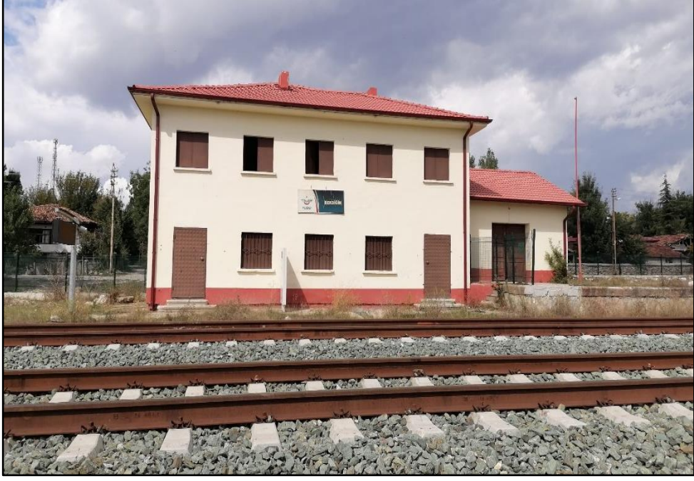
Şekil 5.70. Bekdiğın Tren İstasyonu
