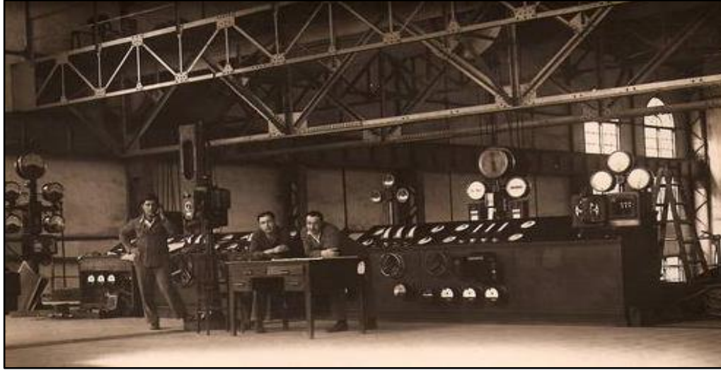
Şekil 4.12. Silahtarağa Elektrik Santrali Faaliyet Dönemi (Global Sanayici Dergisi, 2013)
