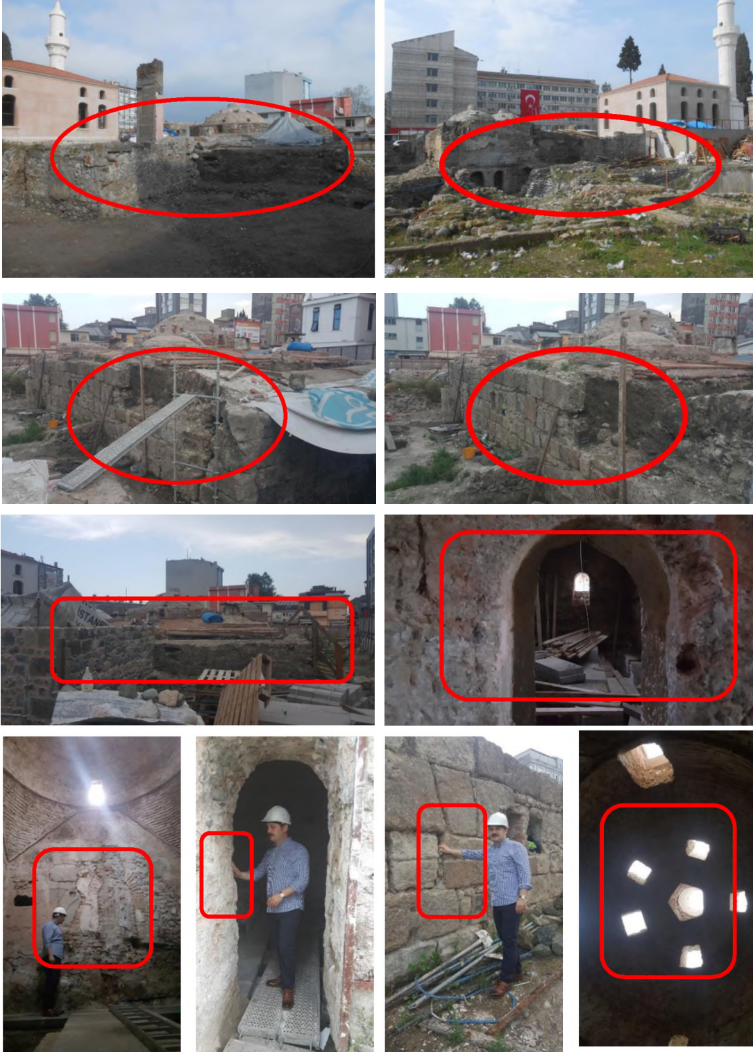
Şekil 6.57. Samsun Şifa Hamamı'na ait örneklemelerin alındığı bölgeler
