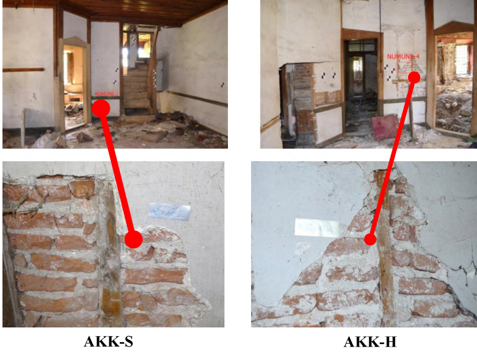
Şekil 6.96. Alaçam Kitaplı Konağı Yapısı'na ait örneklemelerin alındığı bölgeler
