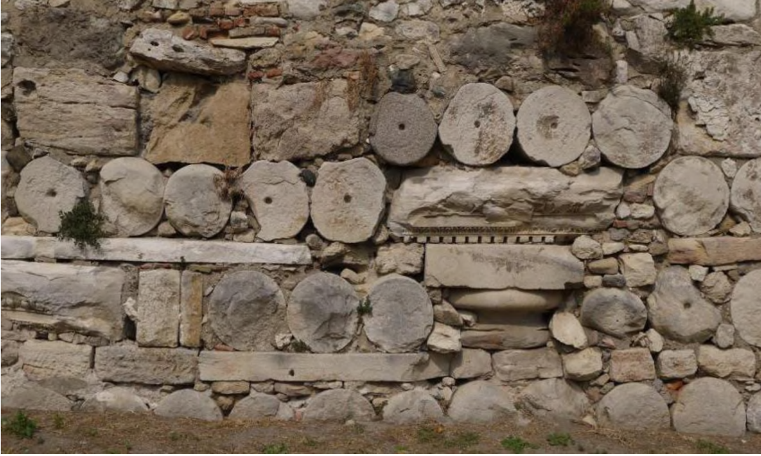
Şekil 5.66. İç kalenin kuzeydoğu köşesinde duvar örgüsü (Atmaca, 2017)
