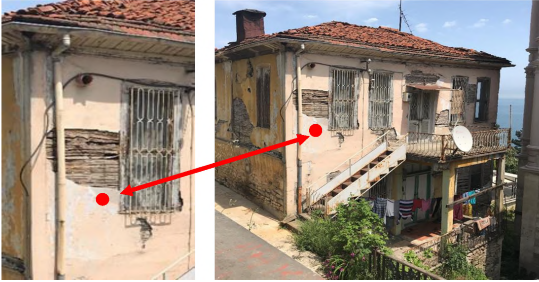
Şekil 6.19. Ordu Sivil Mimari Örneği-3 örneklemelerin alındığı bölgeler
