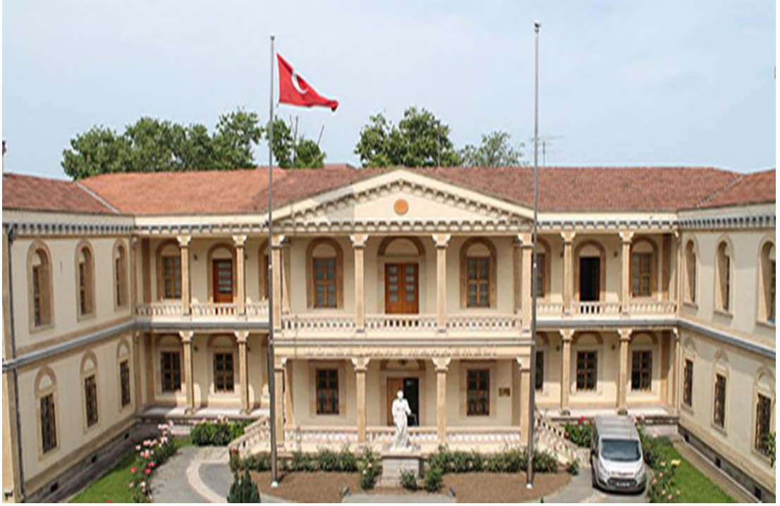
Şekil 5.43. Samsun Eski Hükümet Binası
