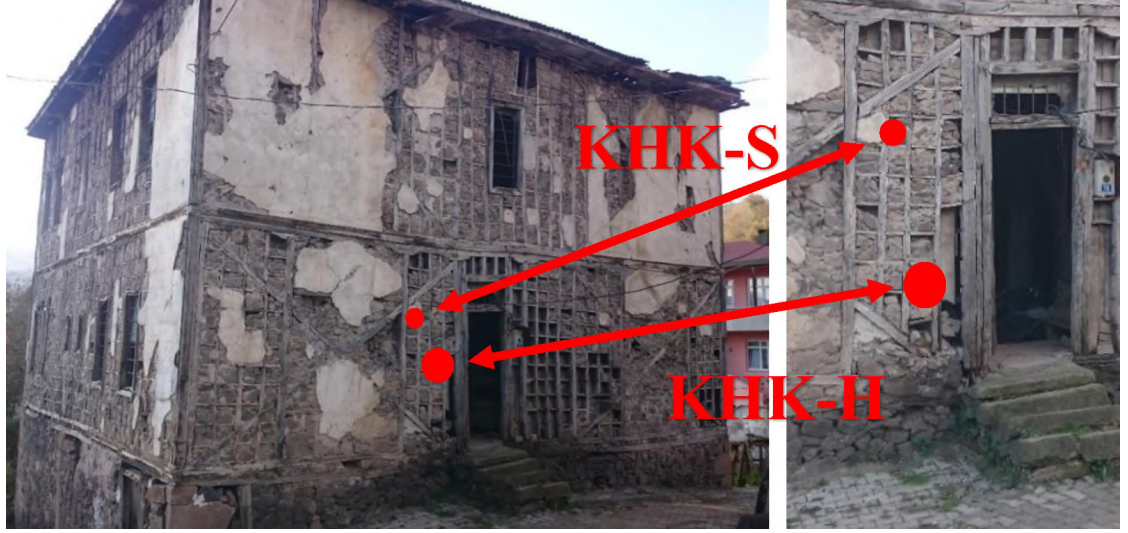
Şekil 6.50. Kabataş Hacı Salih Ağa Konağı'na ait örneklemelerin alındığı bölgeler
