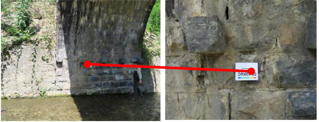
Şekil 6.111. Samsun-Kalın Demiryolu Hattı 33+361 km'de bulunan köprü'ye ait örneklemelerin alındığı bölgeler
