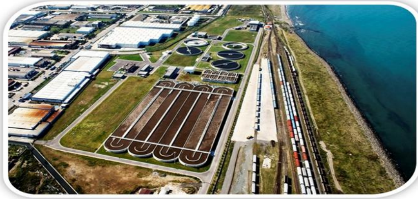
Şekil 3.2. Samsun Doğu İleri Biyolojik Atıksu Arıtma Tesisi (Anonim, 2014ç)
