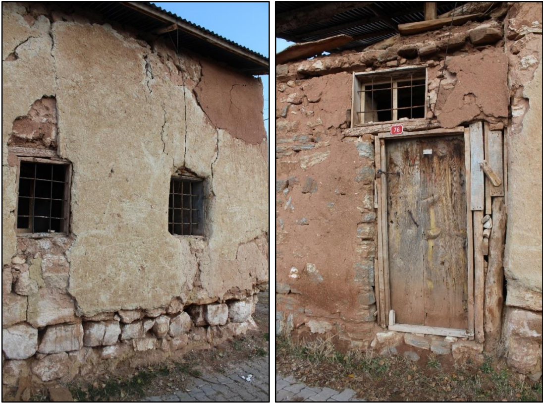
Şekil 3.72. Kerpiç evin pencereleri ve kapısından görünüm
