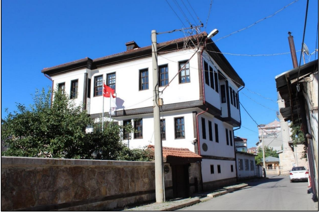
Şekil 3.60. İki katlı Akaylar konağından görünüm
