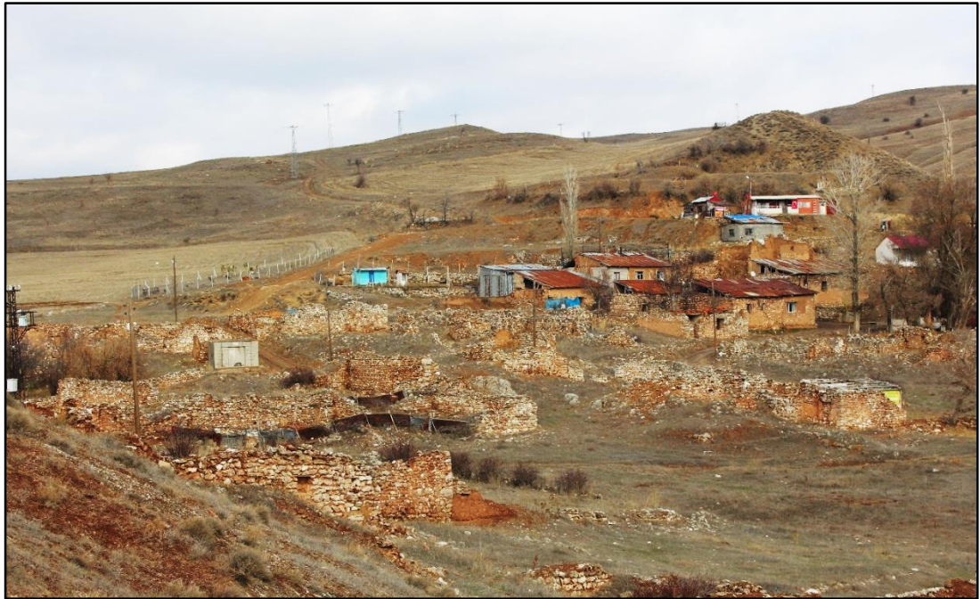
Şekil 2.22. Şehir merkezine yakın Çerçideresi köyünde göç sonucu terk edilen evler
