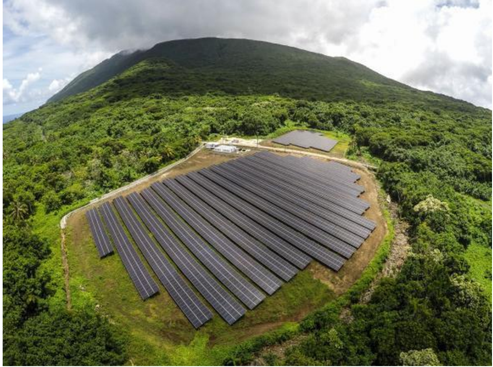
Şekil 2.9. Tau Adasında Kurulu 1.4 MW Kapasiteli PV Enerji Santrali (Hojabri and Toudeshki, 2013)
