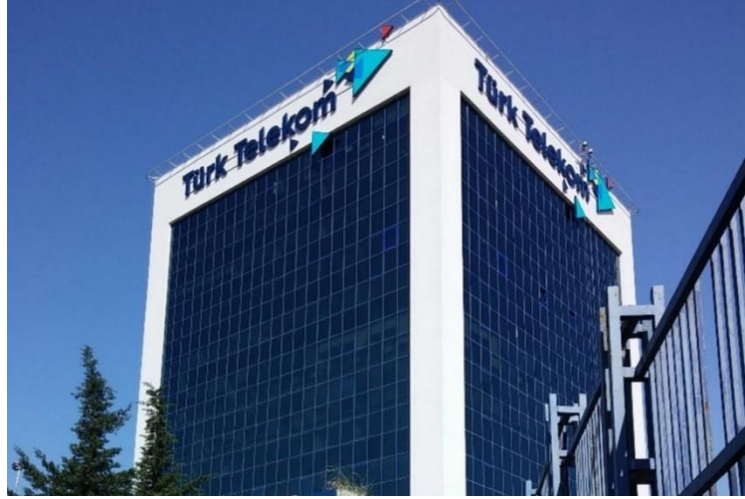
Şekil 3.54. Türk Telekom İstanbul Bölge Müdürlüğü Binası
